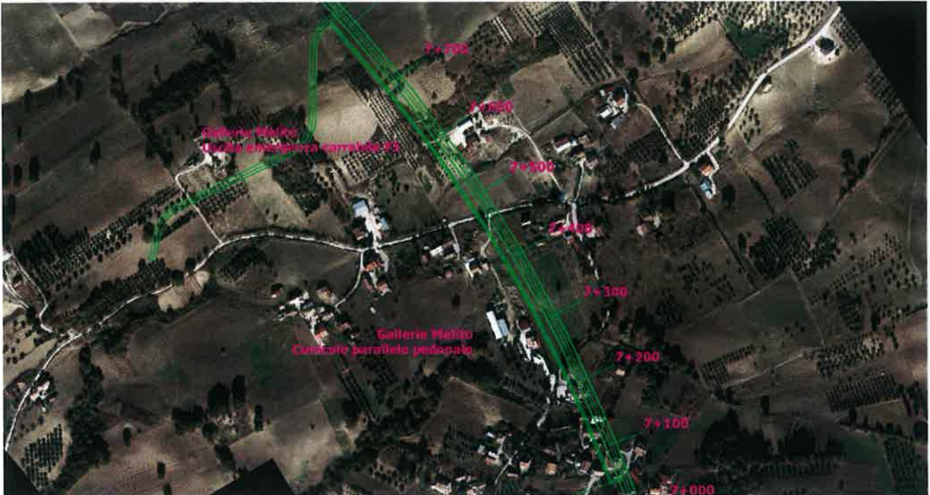
Figura 37. Ortofoto del tratto di galleria Melito compreso tra le pk 7+000 e 7+800
