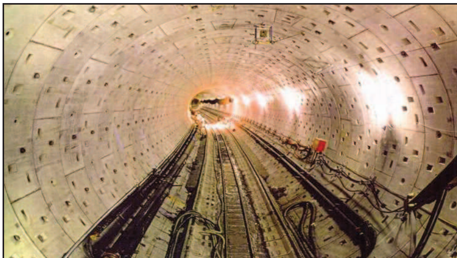
Figura 9– Galleria realizzata con TBM
