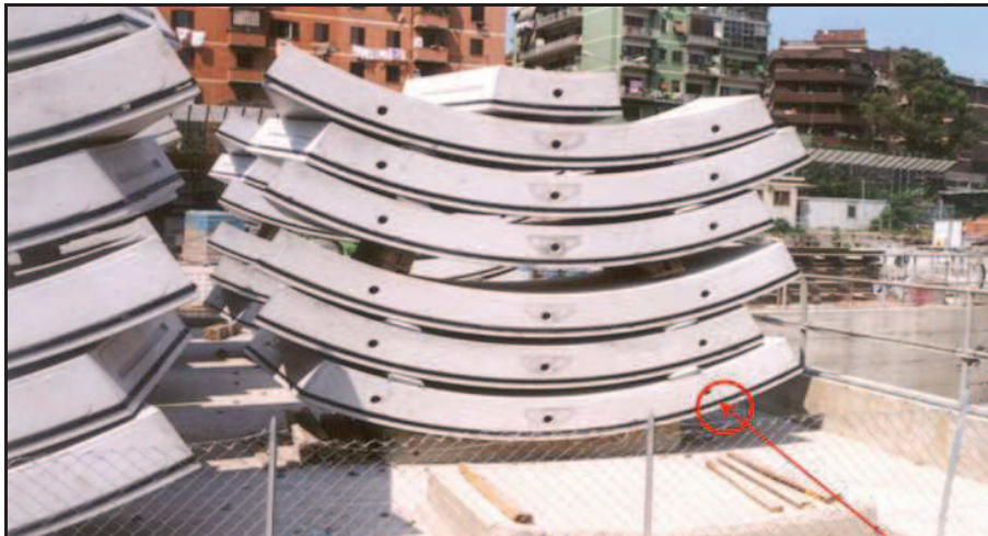
Figura 8– Conci prefabbricati con guarnizioni in neoprene a tenuta idraulica
