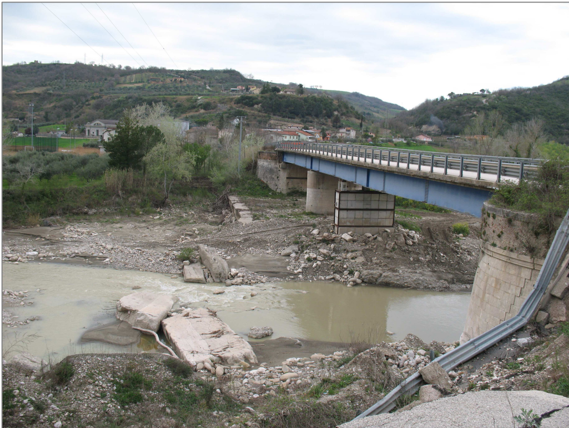
Figura 10 – Stato dei luoghi: zona interessata dalla realizzazione del Viadotto Ufita Apice - VI04, Torrente Ufita, Ponte Stradale esistente immediatamente a monte del nuovo attraversamento ferroviario (foto del 27.03.2017)
