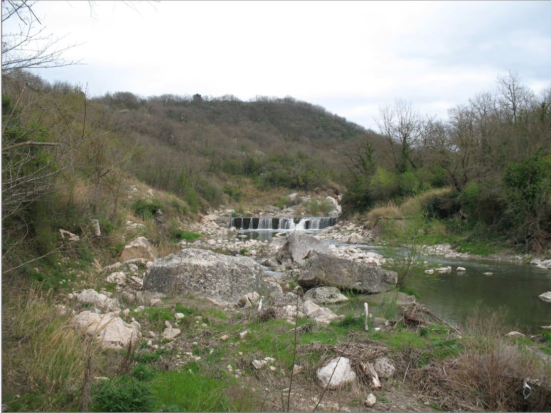
Figura 5 – Stato dei luoghi: zona interessata dalla realizzazione del Viadotto Ufita Melito - VI02, Torrente Ufita
