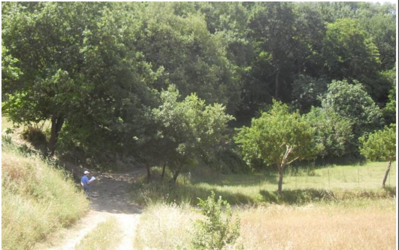
Foto 35 – vista cantiere di galleria GN.11 (uscita F6 galleria Rocchetta)
