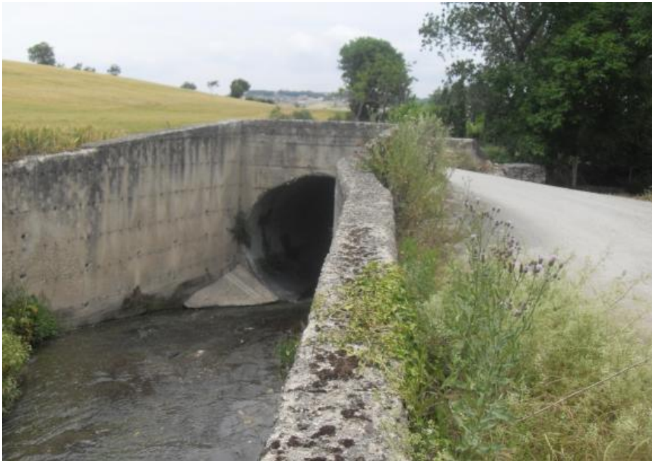
Foto 7 lungo la viabilità di accesso all'area (particolarità di un attraversamento idraulico con tubo metallico esistente)
