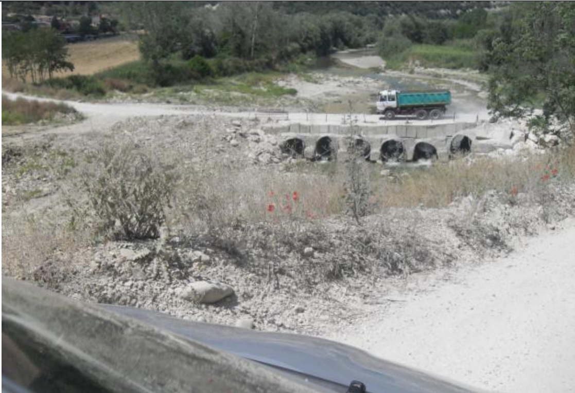
Foto 45 – vista del guado attuale sul fiume Ufita
