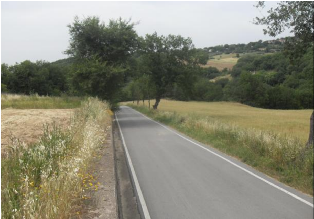
Foto 11 – vista della viabilità di accesso CB.02
