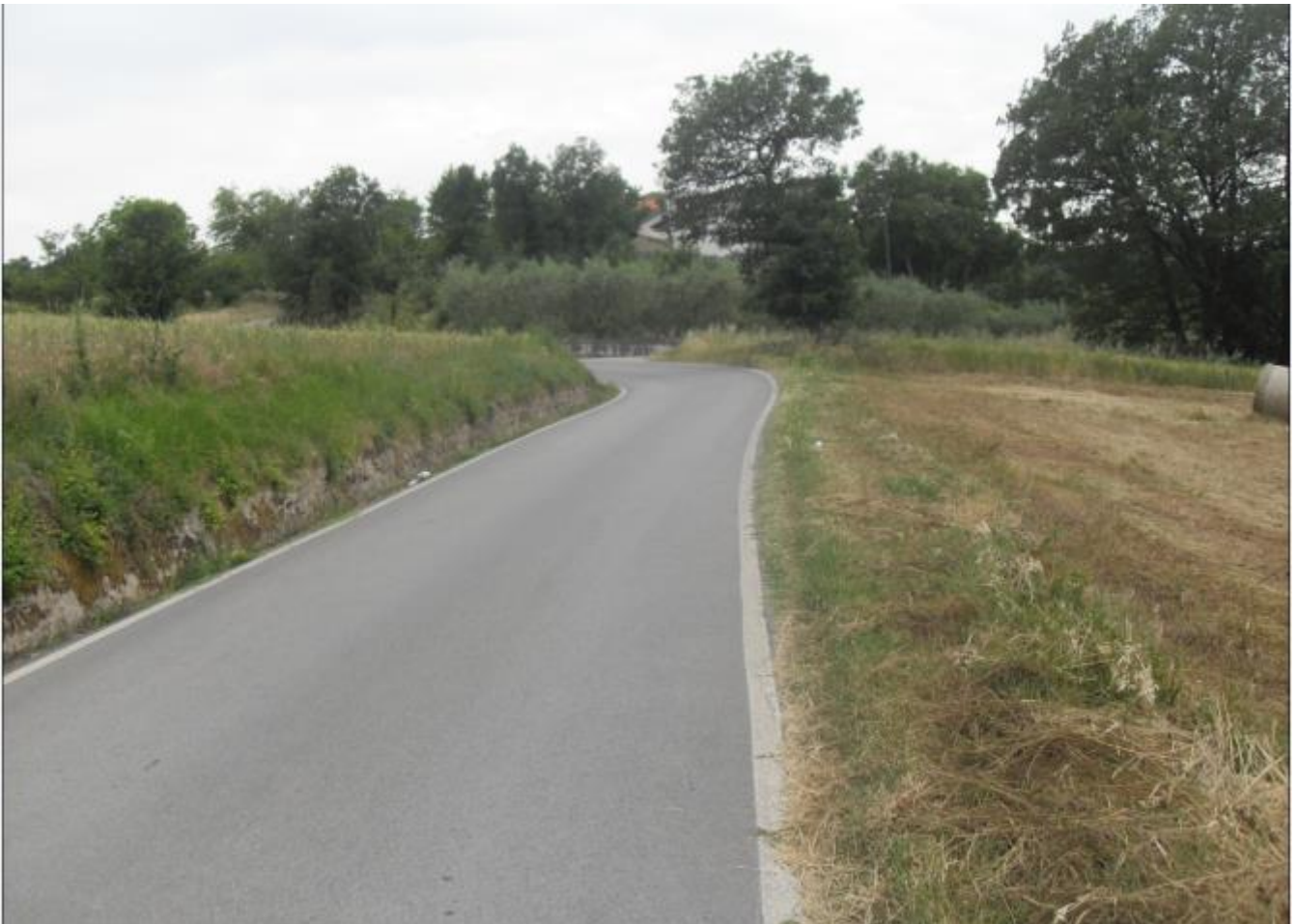
Foto 14 – vista area cantiere di galleria dalla viabilità interferente
