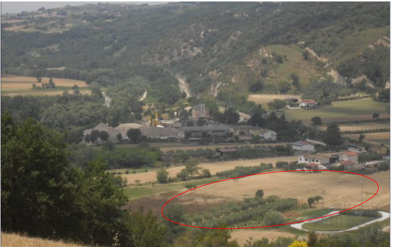
Foto 43 – vista dell'area AT.07 dal sito del cantiere GN.12
