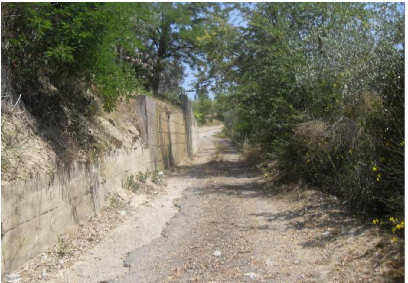
Foto 39 – vista viabilità di accesso da adeguare
