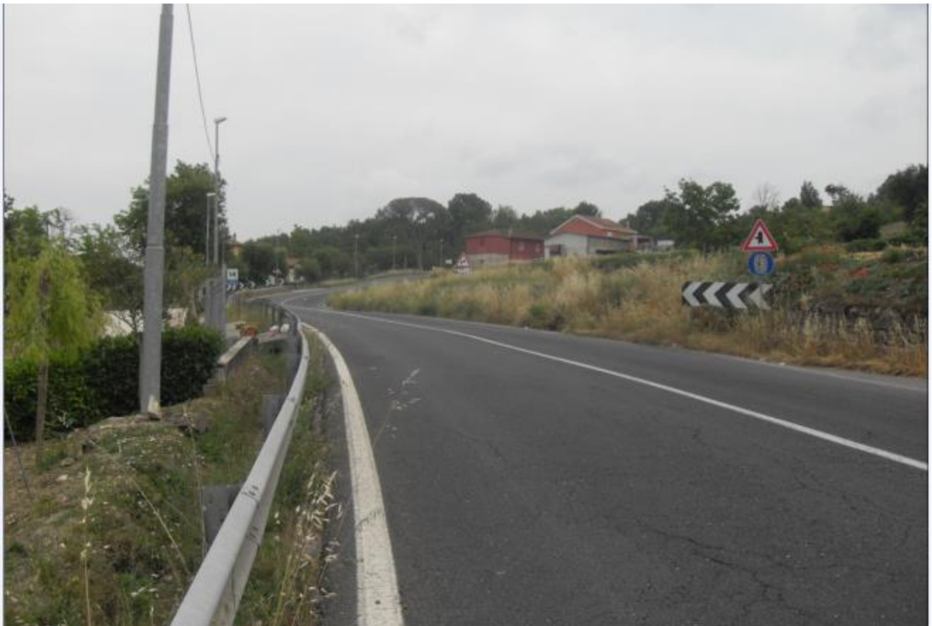
Foto 18 – vista zona della pista d'accesso alla Finestra 1 sulla SS90
