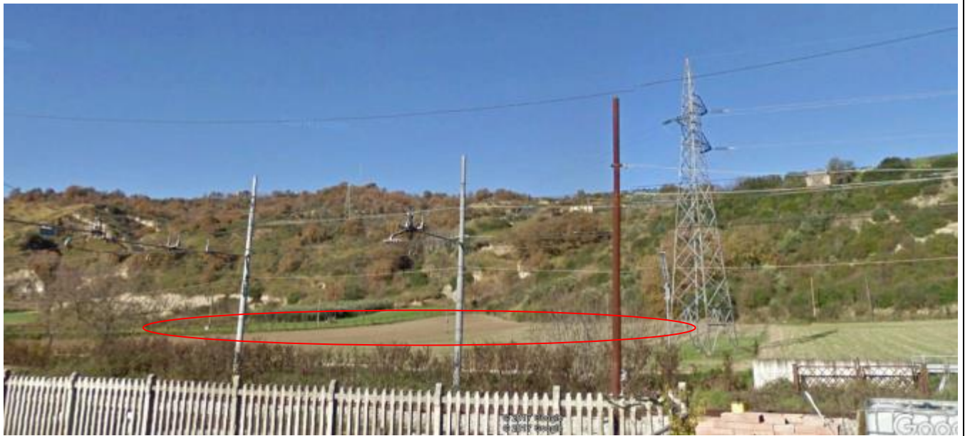
Foto 46 – vista dal CB.03 dalla viabilità lungo la stazione di Apice
