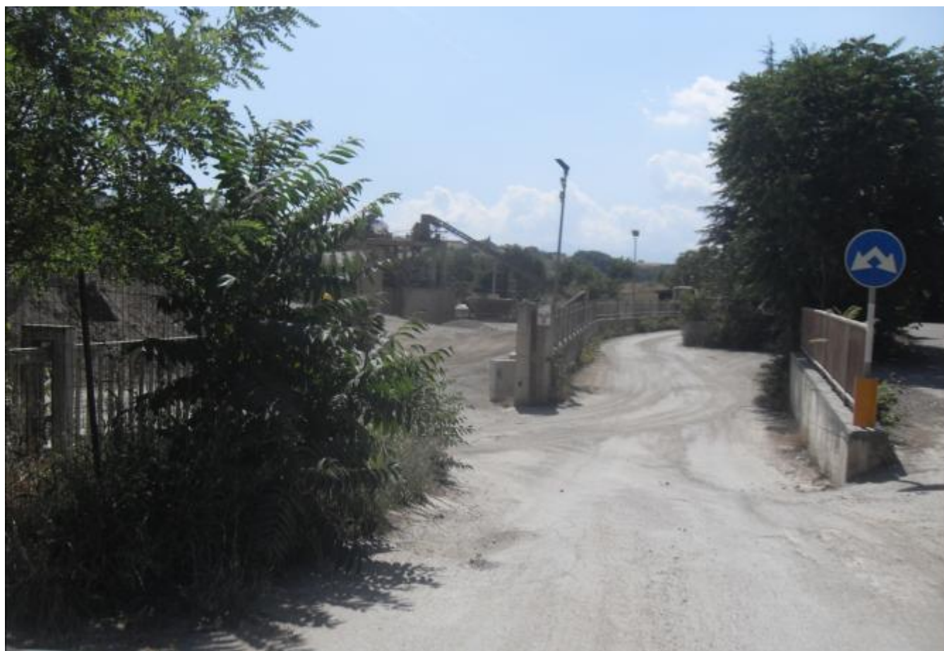
Foto 49 – vista dell'attuale impianto di lavorazione inerti e cls oggetto di esproprio e interessato dall'impianto del cantiere armamento CA.01
