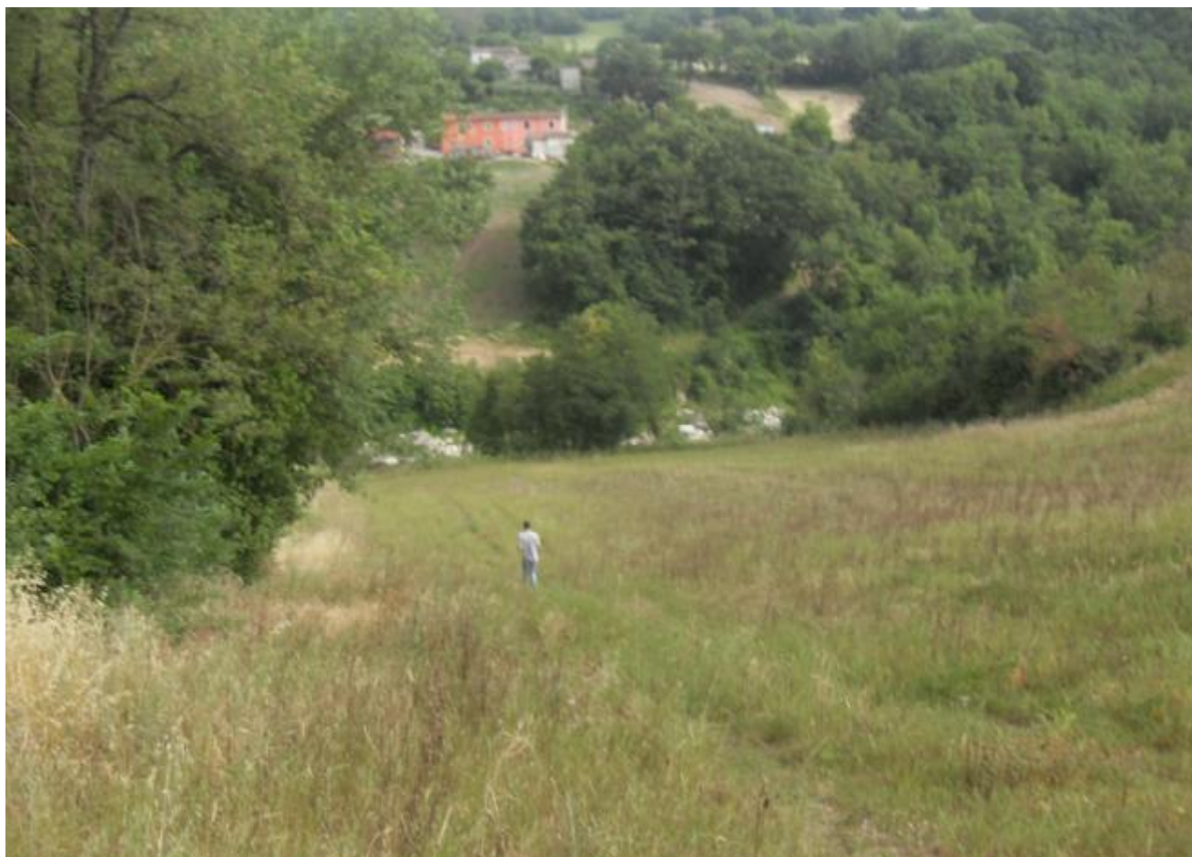
Foto 19 – vista lato fiume cantiere di galleria GN.04 (galleria Melito imbocco Bari)
