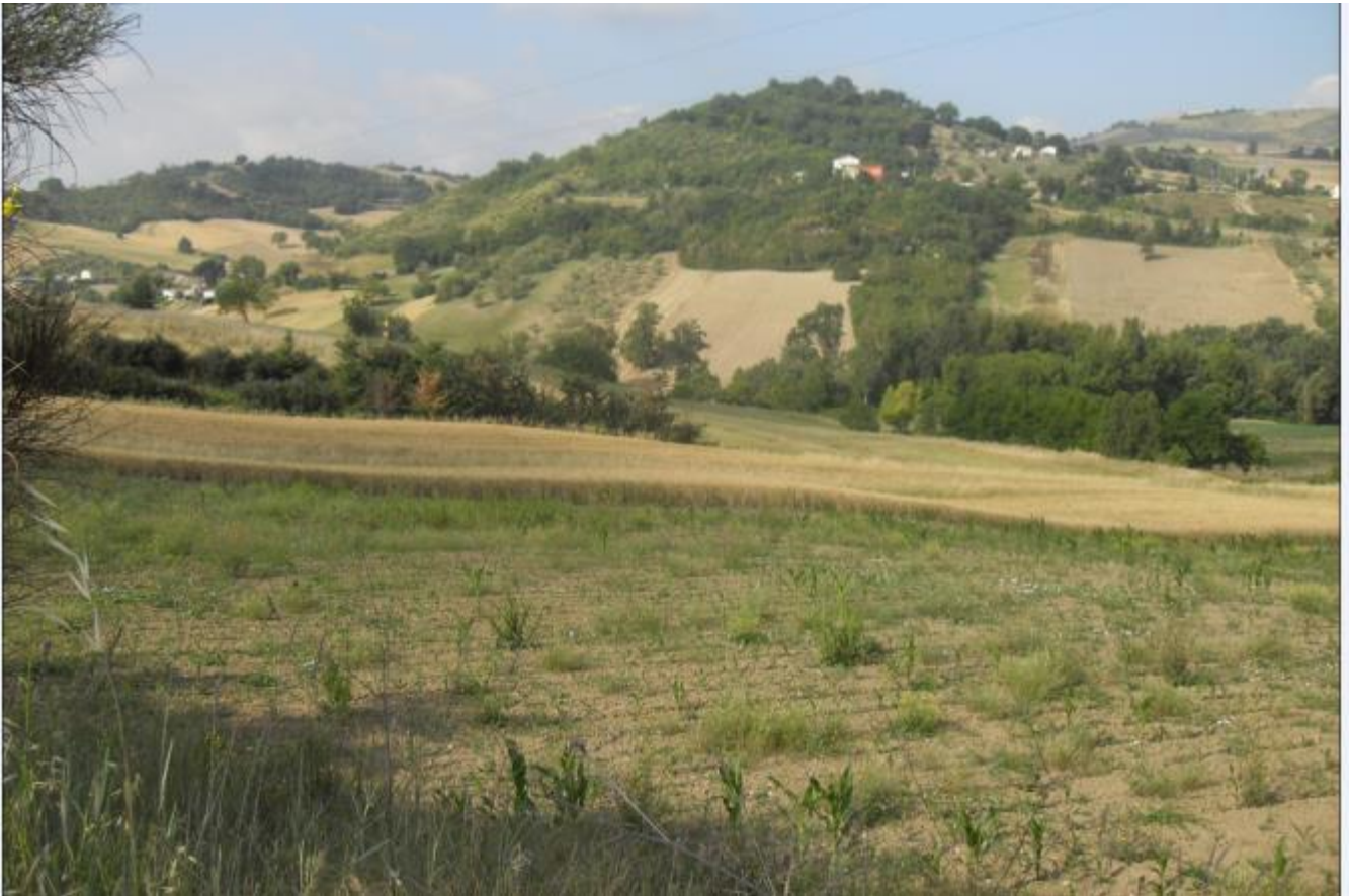
Foto 27 – vista cantiere di galleria GN.08 (galleria Melito imbocco lato Napoli)
