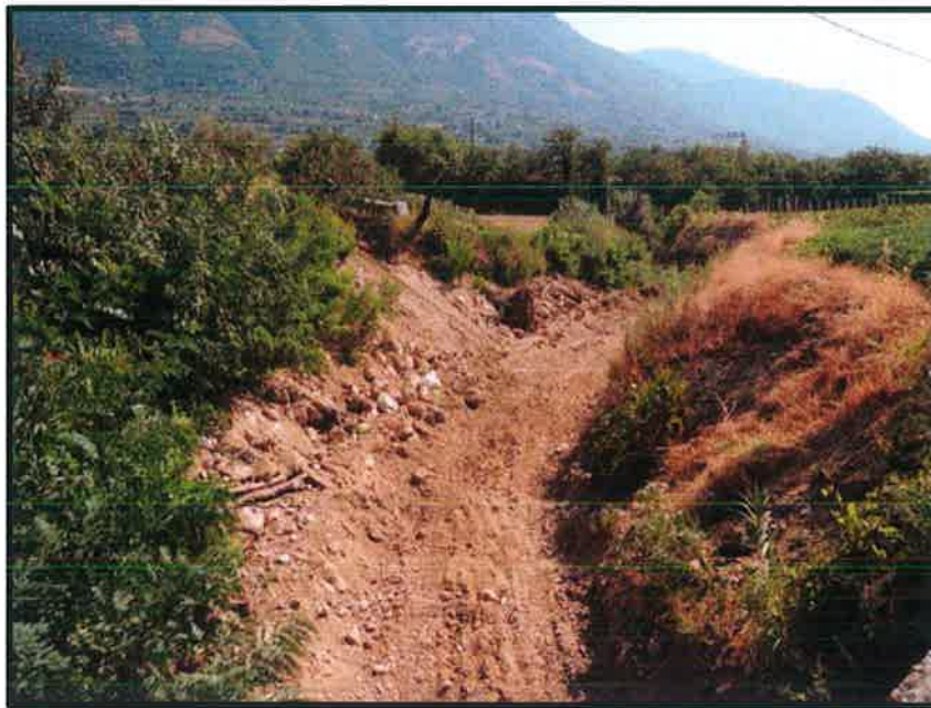
Figura 7-9 – Letto del torrente a nord del fiume Calore. Sullo sfondo la fascia boscata lungo la linea ferroviaria esistente. Si osservi la mancanza di fascia ripariale.
