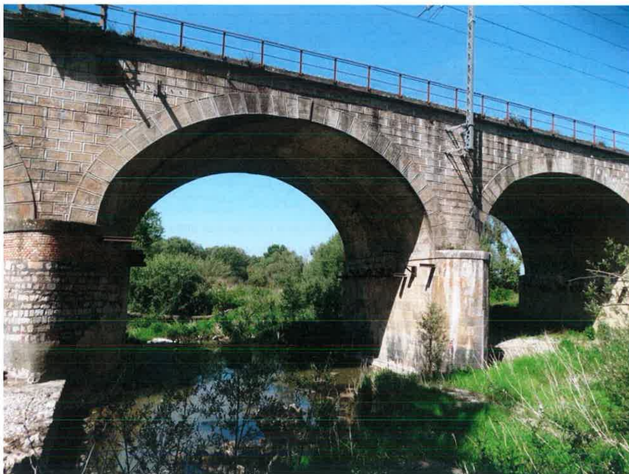
Figura 7-16 - Zona umida perifluviale di acqua stagnante formatasi sotto l'attuale viadotto (ferrovia + strada provinciale 335) situato tra i comni di Amorosi e Melizzano.
