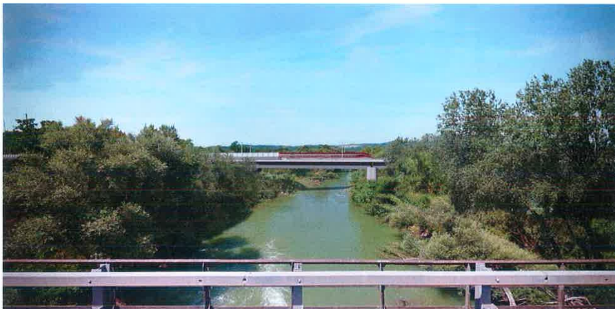
Figura 9-6 – Foto del fiume Calore post-operam, con gli interventi di mitigazione.
