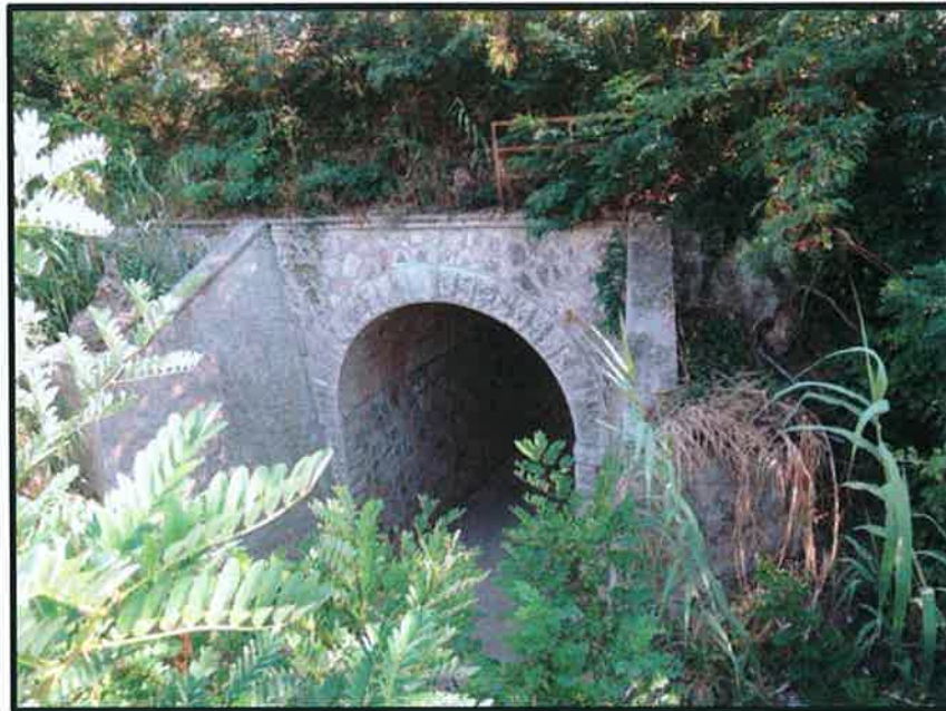
Figura 7-10 – Letto del torrente sotto il cavalcavia della linea ferroviaria esistente.
