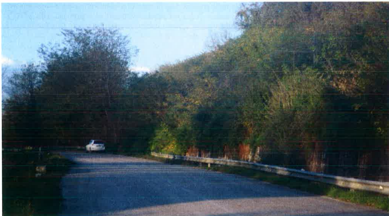
Foto 13 – Vista panoramica del settore centrale del tratto in esame, a SSE del centro abitato di Castel Campagnano in località Fiumara.
