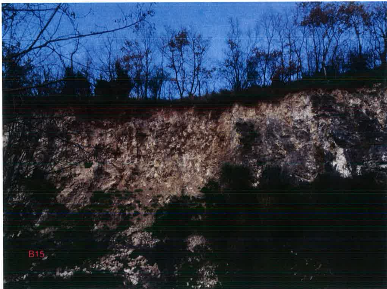
Foto 10 – Fenomeni di crollo s.l. che interessano i termini calcareo-marnosi delle Argille Varicolori Superiori.
