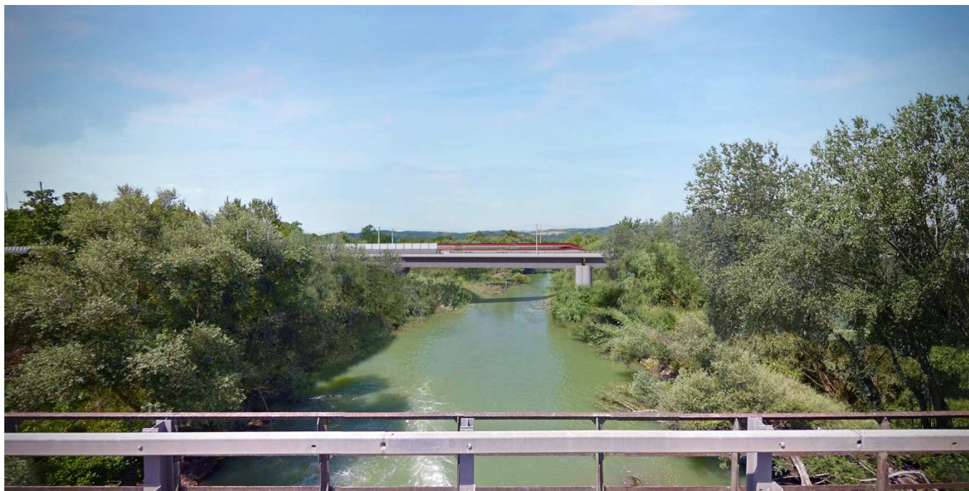
Figura 4-36 - Foto post-operam, con interventi di mitigazione.
