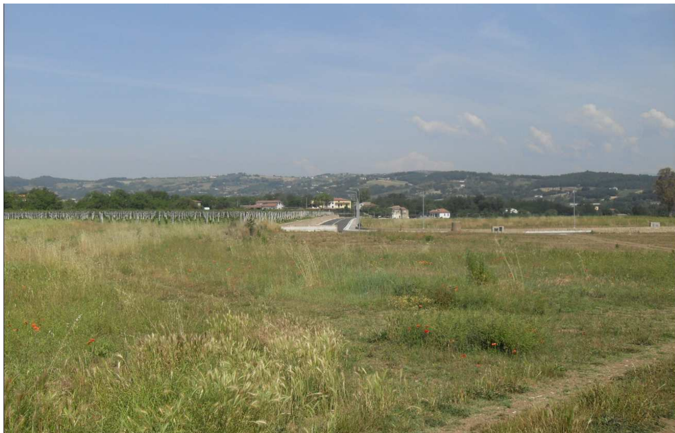
Figura 5-4 – Foto del cantiere AR1L1.
