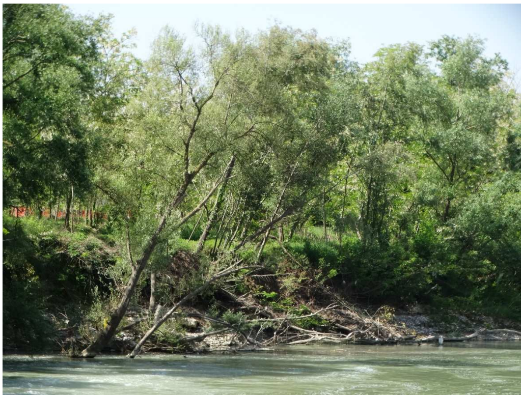
Figura 5-10 – Vegetazione spondale del Calore alla progressiva 20+500 circa.
