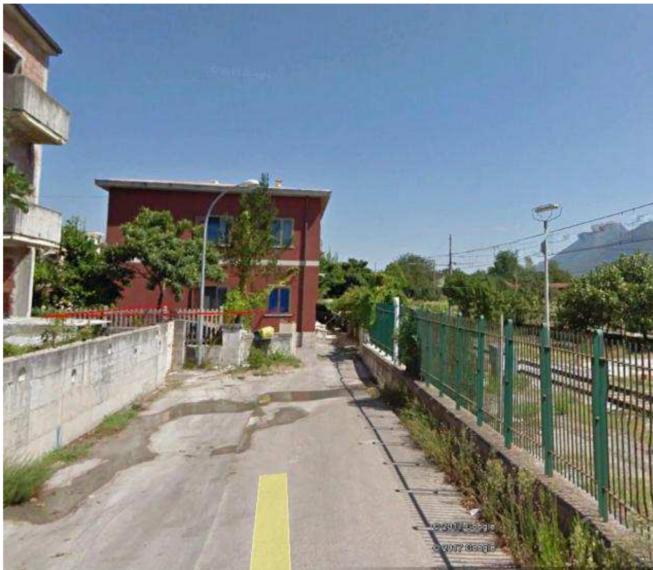
Foto 6 – vista fabbricato oggetto di demolizione
