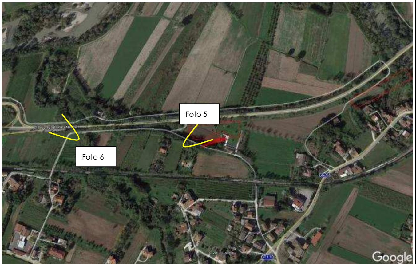
Vista aerea cantiere AT2L1
