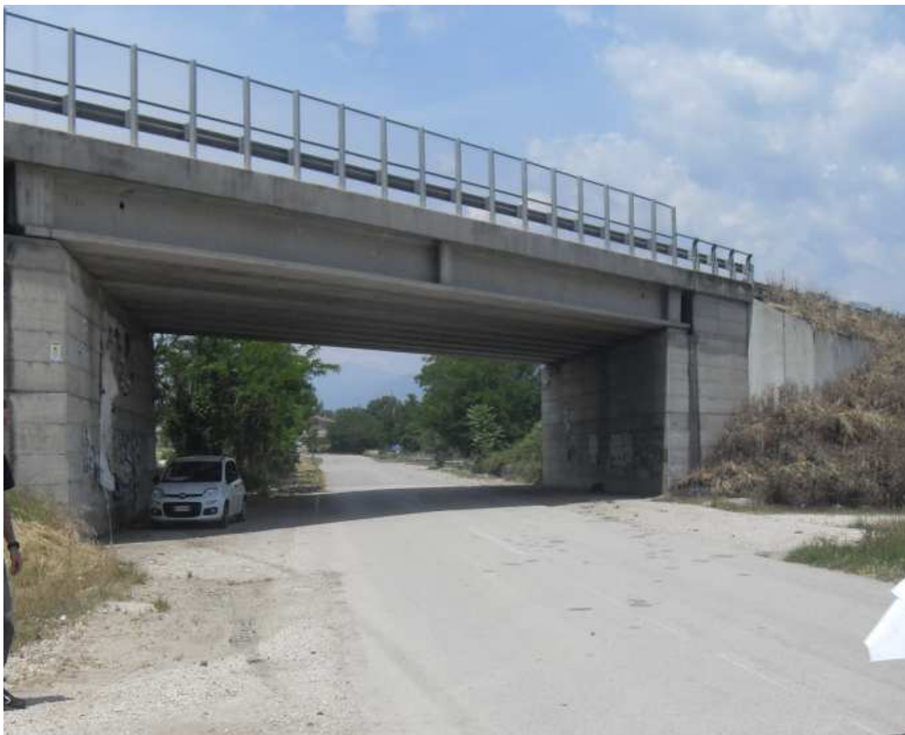
Foto 3 - vista viabilità di accesso al cantiere CO1L1
