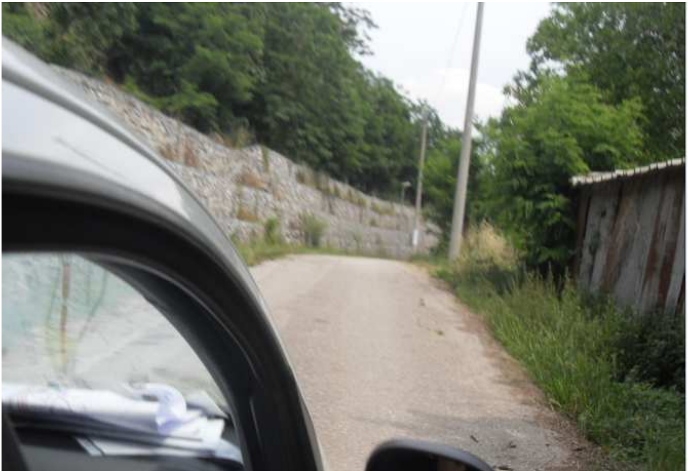
Foto 7 – vista accesso all'area di galleria e area impianto cantiere
