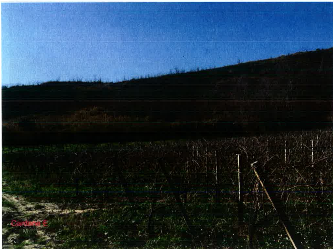
Foto 16 - Vista panoramica del versante dove è previsto l'imbocco est della galleria Cantone.
