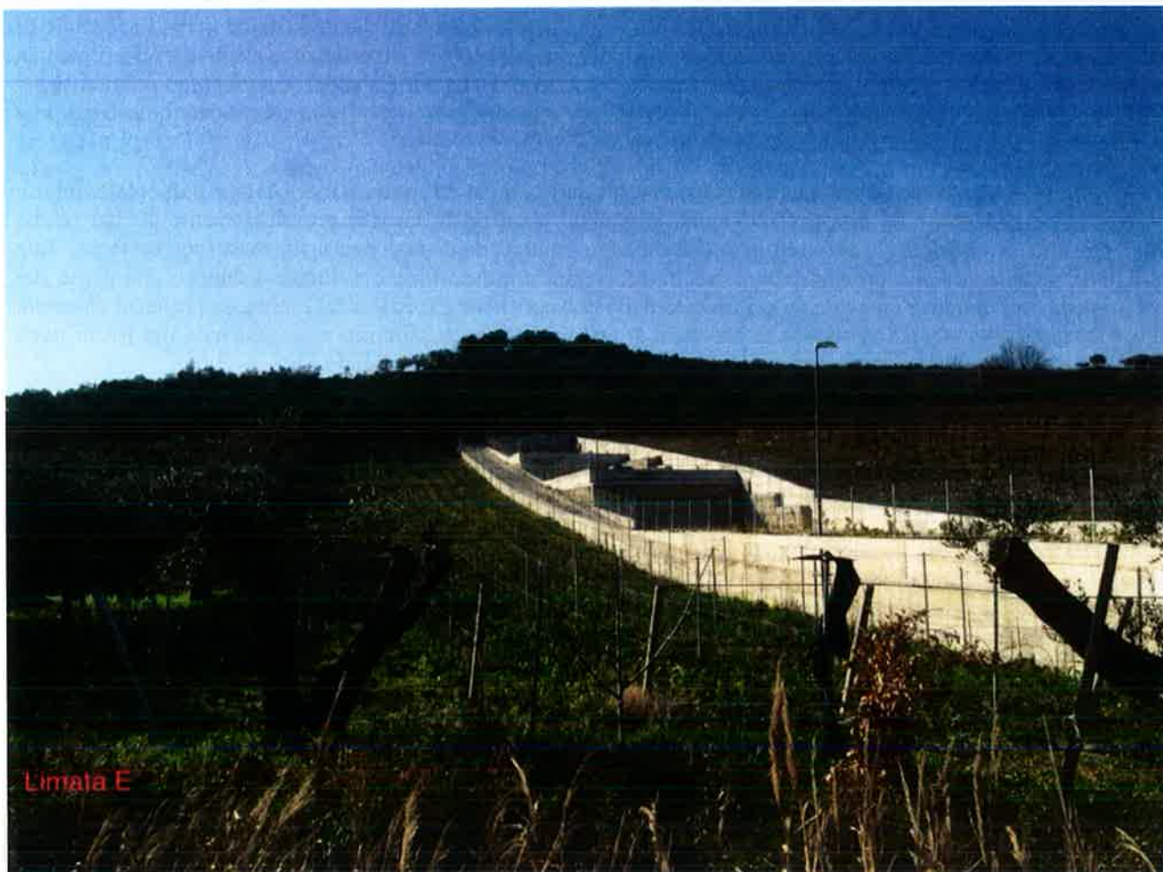
Foto 13 – Panoramica del settore d’imbocco della galleria Limata lato Benevento.
