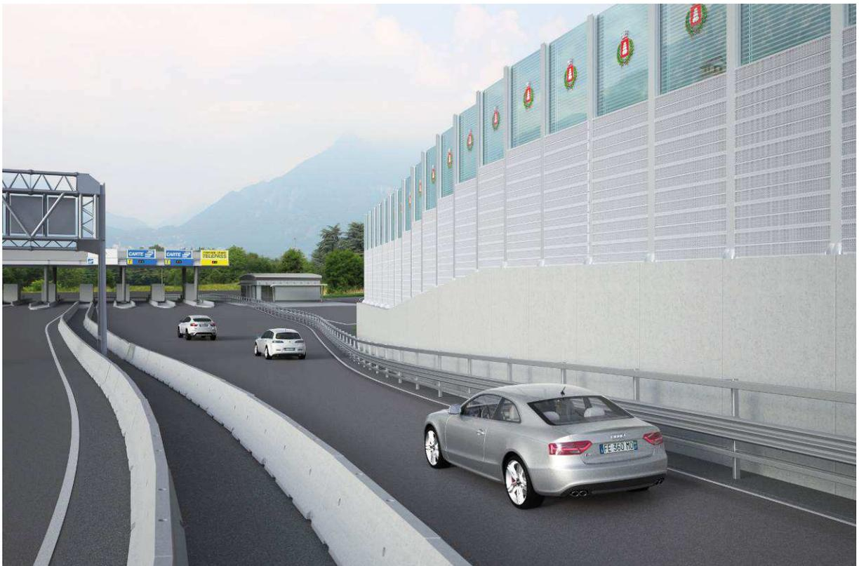
Figura 63: Barriera antirumore in plastica riciclata e PMMA, con colori e stemma del Comune di Cogollo del Cengio
