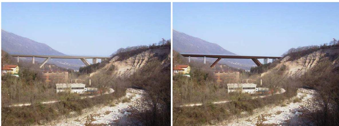
Figura 44: Studio di colori e materiali per il Viadotto Piovene: a sinistra, impalcato e cavalletto in acciaio Cor-ten trattato superficialmente con vernice color greto dell’Astico – la soluzione risulta non percorribile, in quanto si andrebbe a contraddire la specificità dell’acciaio Cor-ten, con notevoli aumenti dell’importo dell’opera, a carico dei trattamenti superficiali; a destra, opera d’arte maggiore bicromatica, scelta considerata poco consona con il paesaggio in cui si inserisce
