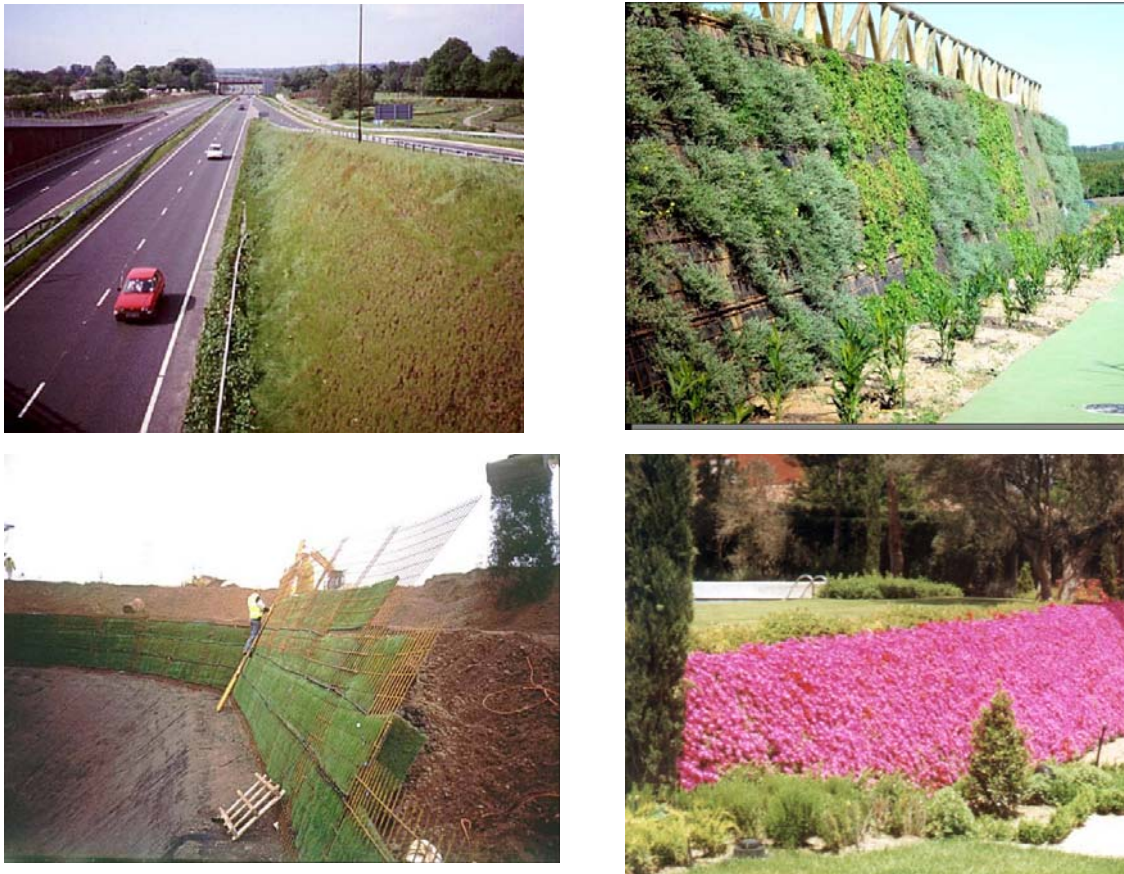
Figura 103: Esempi delle fasi di costruzione e dell'opera finita di terre rinforzata e con paramento a verde.
