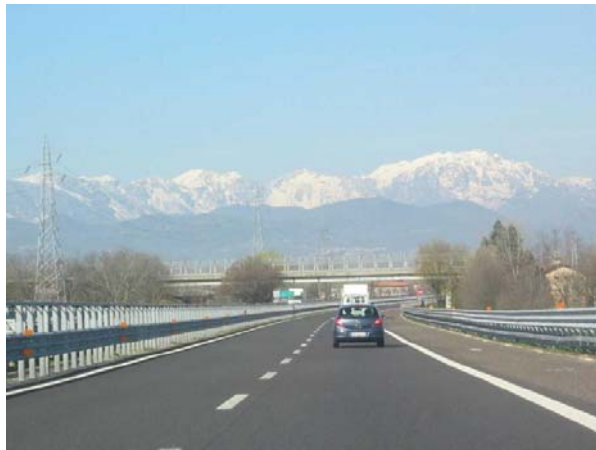
Figura 1: foto del tratto esistente della A31
