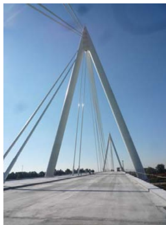
Figura 2: foto dei cantieri di costruzione del tratto a Sud – costruzione viadotto strallato sul fiume Adige
