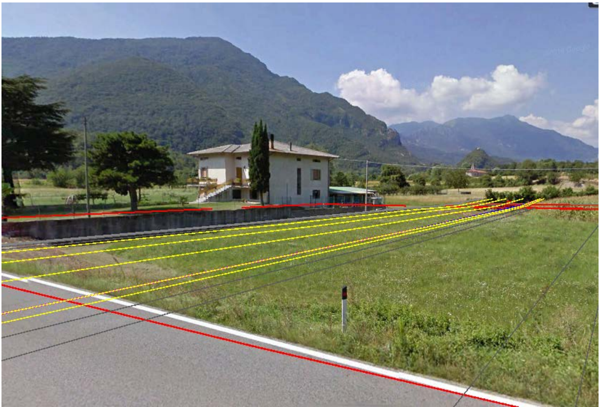
Figura 28 – edificio esistente in prossimità della berlinese di sostegno dello scavo per la realizzazione della galleria artificiale
