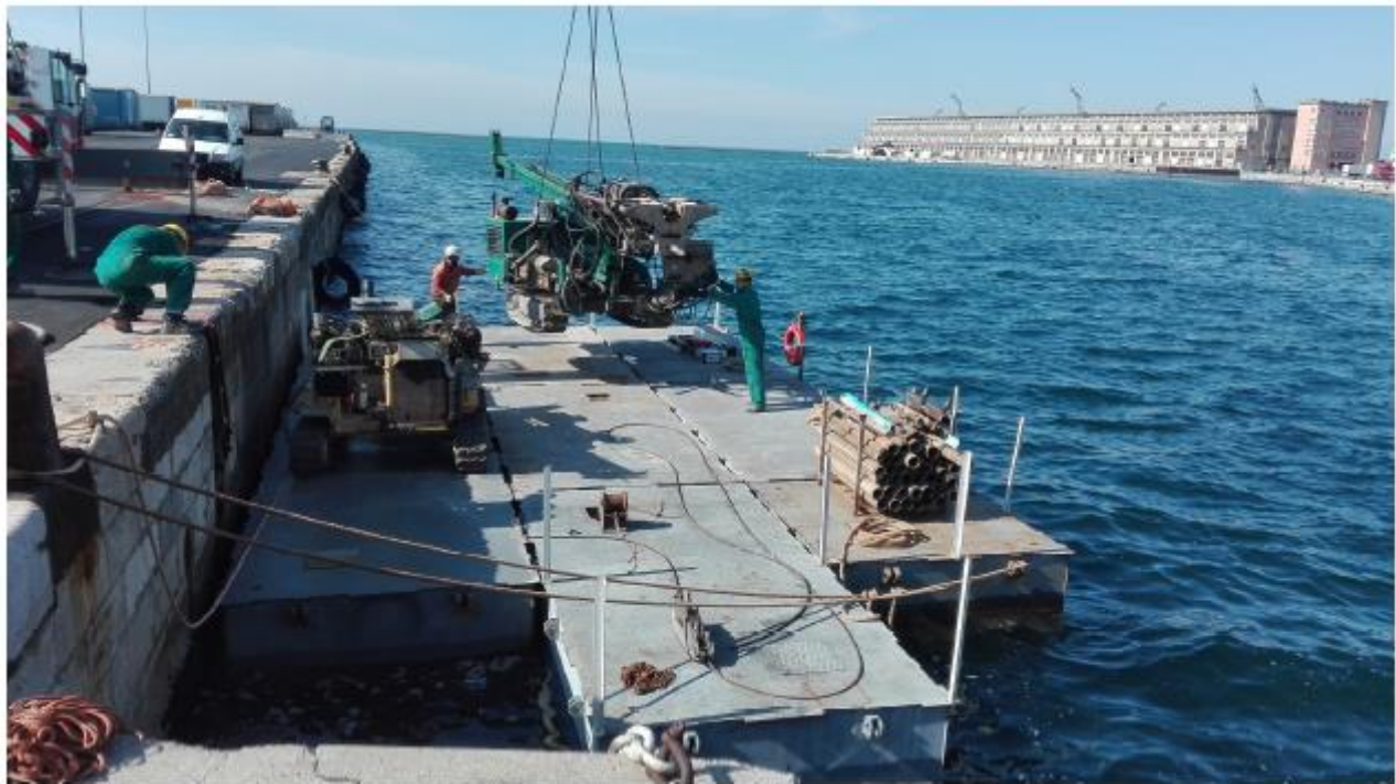
Figura 4: Fase di imbarco delle attrezzature sulla piattaforma
