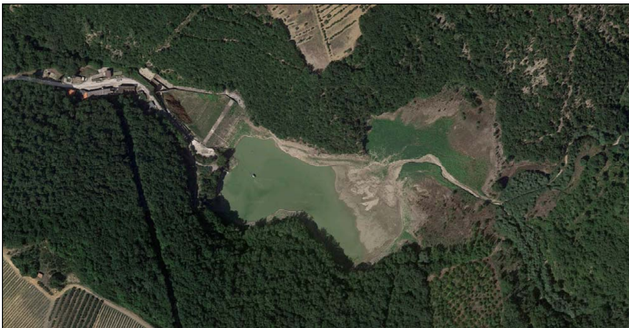
Figura 2-5 – Vista aerea della diga di Cepparello con limitazione di invaso alla quota di 177.0 m s.l.m..
