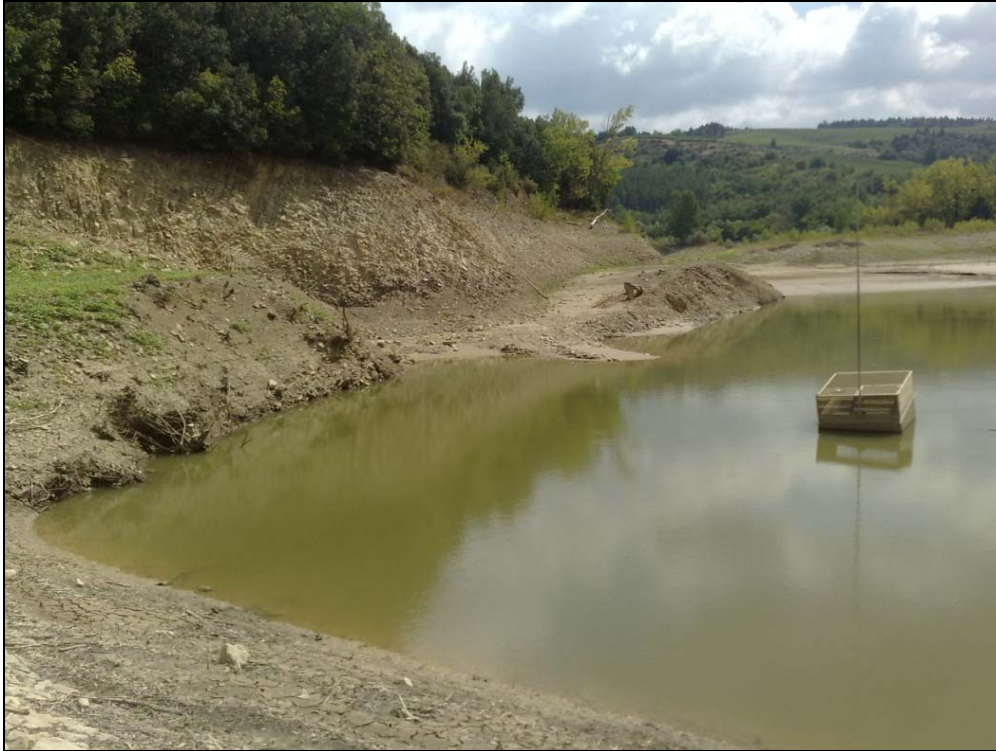
Figura 2-8 – Opera di presa esistente (estate 2003).
