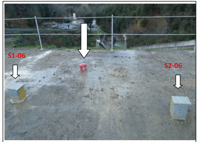
Pozzetto piezometri di S4-16
