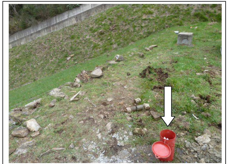
Pozzetto piezometri di S6-16
