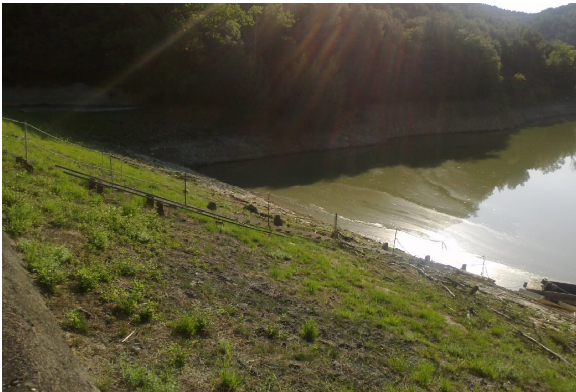
Figura 35 – Paramento di monte
