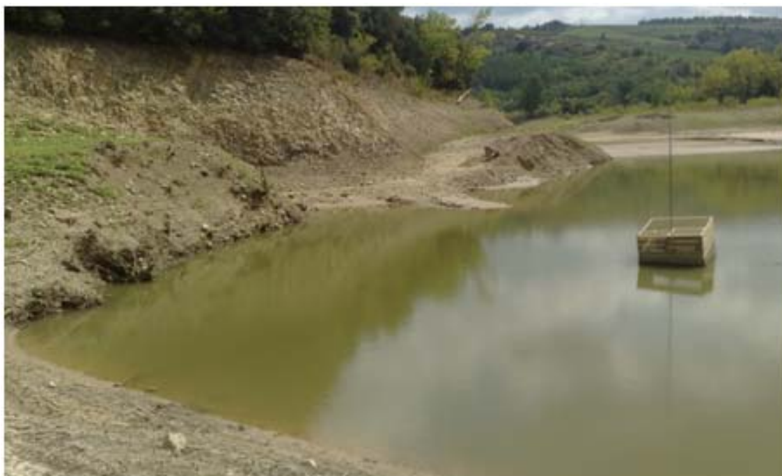
Figura 40 – Opera di presa
