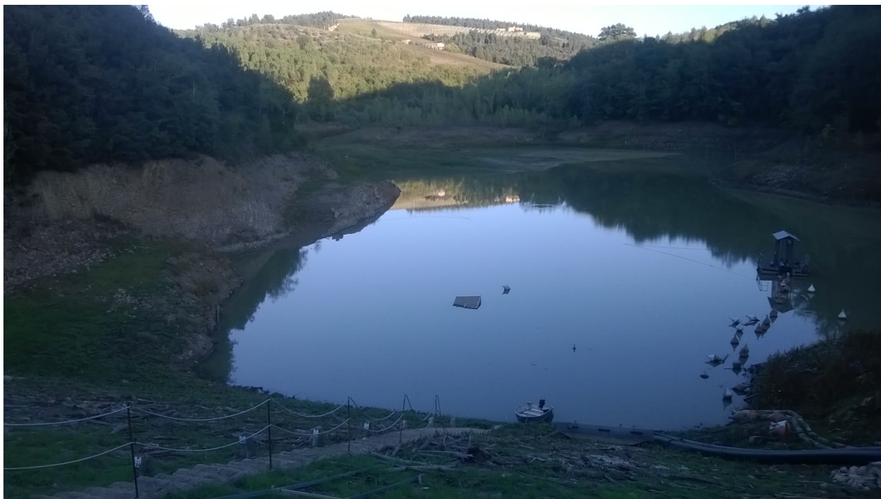
Figura 4 – Area dell’invaso vista dal paramento
