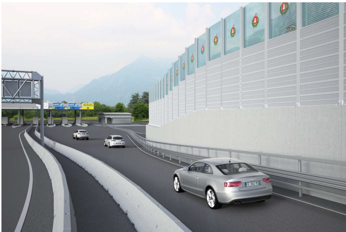
Barriera antirumore in plastica riciclata e PMMA, con colori e stemma del Comune di Cogollo del Cengio; fotoinserimento del casello di Cogollo del Cengio
