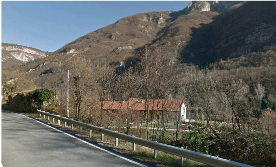
Figura 4 Edificio da demolire in località Barcarola con la Variante "D"
