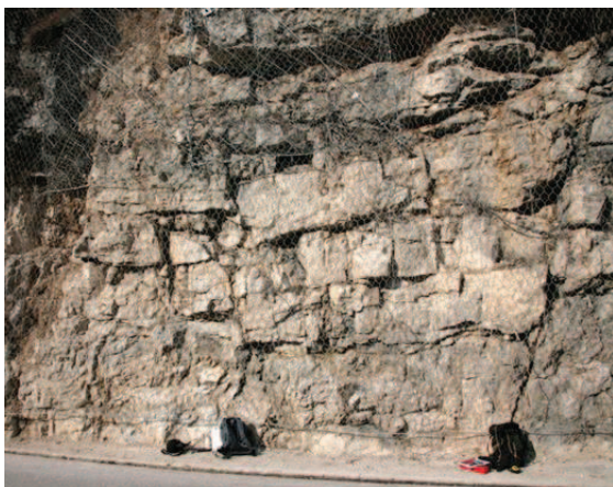
Figura 5.14- Geologia – Sequenza stratigrafica – Affioramento della Dolomia Principale presso Valdastico e Pedemonte
