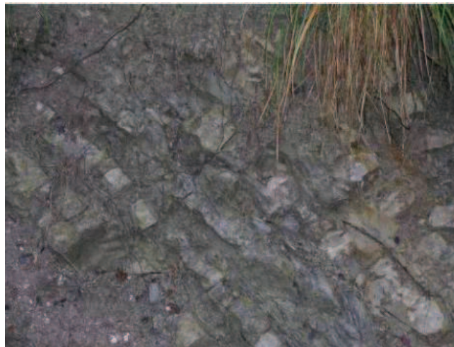
Figura 5.11 - Geologia – Sequenza stratigrafica – Affioramento della formazione dei Calcari della val Gola (da M.Avanzini, Seminario intermedio – Fogli Trento e Mezzolombardo – Le unità sedimentarie: nomenclatura, proposte, problemi)
