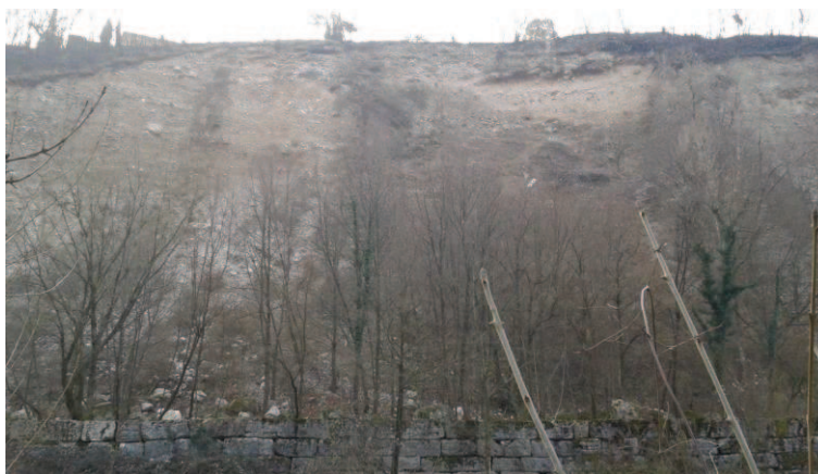
Figura 7.3 - Fenomeno franoso in destra Astico in prossimità del viadotto Piovene. Costituisce un ottimo spaccato che permette di osservare la stratigrafia dei depositi fluvioglaciali inglobanti ciottoli, massi e orizzonti ben cementati
