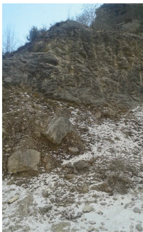
Figura 7.7 - Massi costituenti l'accumulo della Marogna affioranti lungo il fronte di cava.
