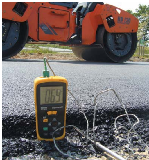
Figura 5: temperatura della miscela durante la compattazione dello strato
