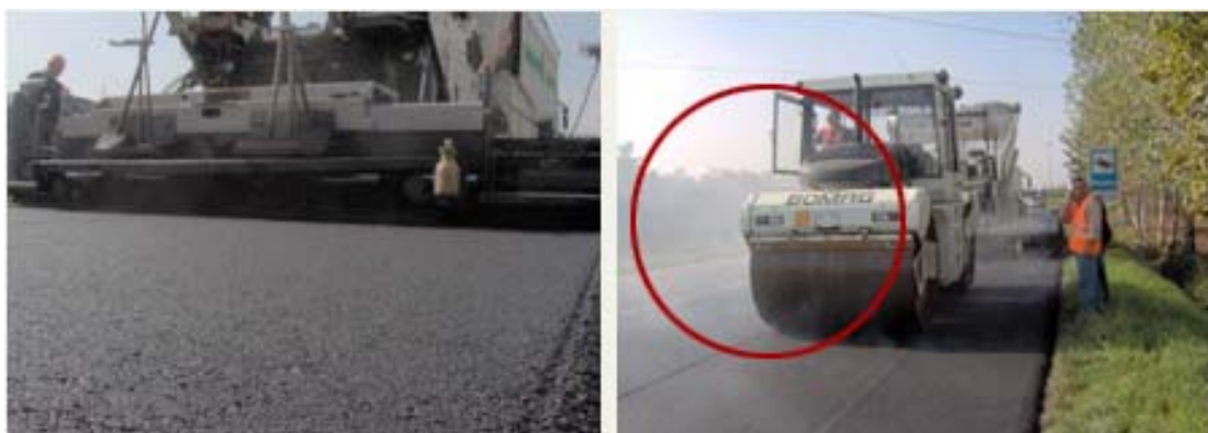
Figura 4: confronto tra conglomerato bituminoso tradizionale e Warm Mix Asphalt in termini di produzione di fumi durante la stesa
