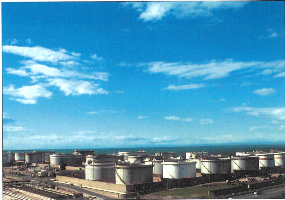
Figura 8.1-B: Vista dell'Area della Raffineria
