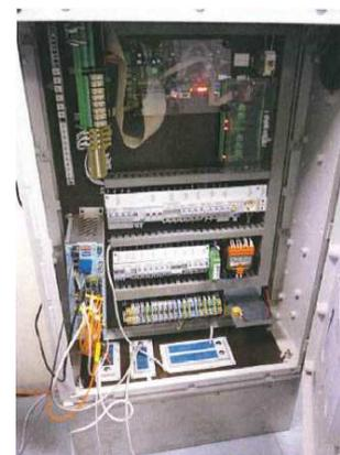
Il calcolatore Cronos necessita di un collegamento alla rete dati e questo sarà assicurato da una dorsale realizzata in fibra ottica a 4 fibre multimodali o in cavo rame CAT6 a seconda della dimensione del casello/sottocasello; il Cronos è già predisposto per entrambe le tipologie di collegamenti: nel caso di collegamento in F.O. occorre considerare un transceiver (mediaconverter Elettrico/Ottico MultiMode) all'interno dell'armadio di casello.
