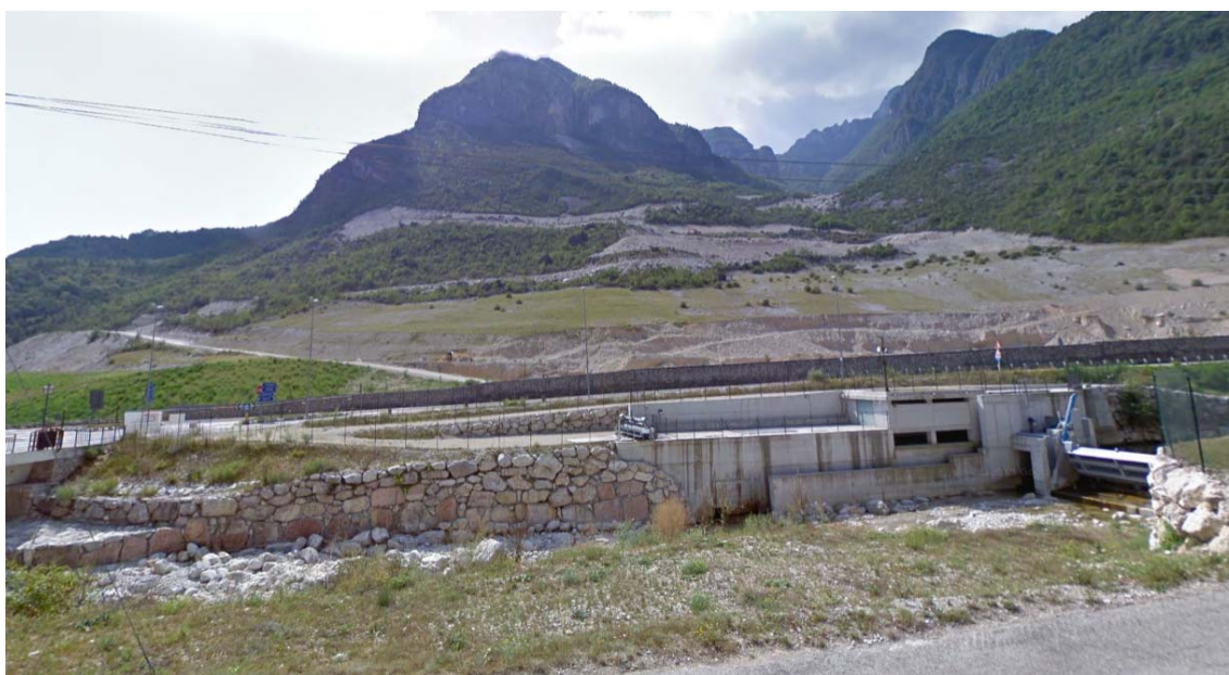
Figura 45 – Vista attuale Cava La Marogna
