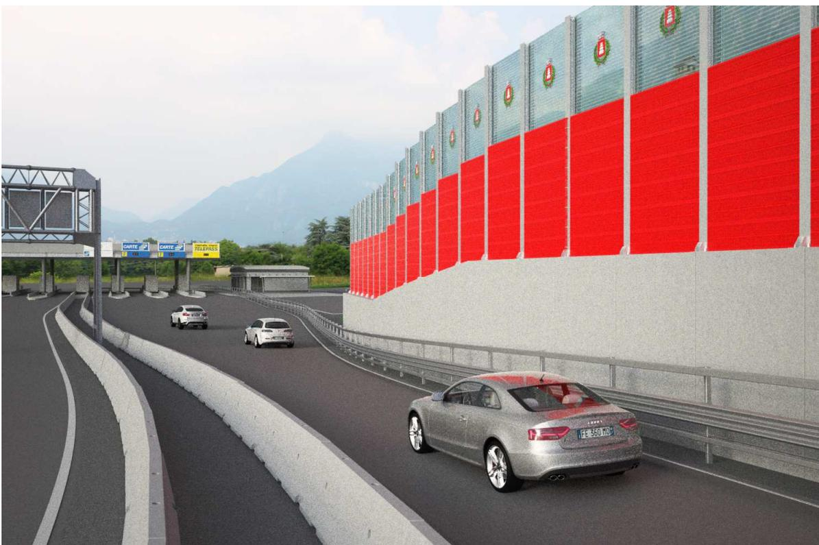
Figura 7: Fotoinserimento delle barriere antirumore in plastica riciclata e PMMA presso lo svincolo di Cogollo del Cengio
