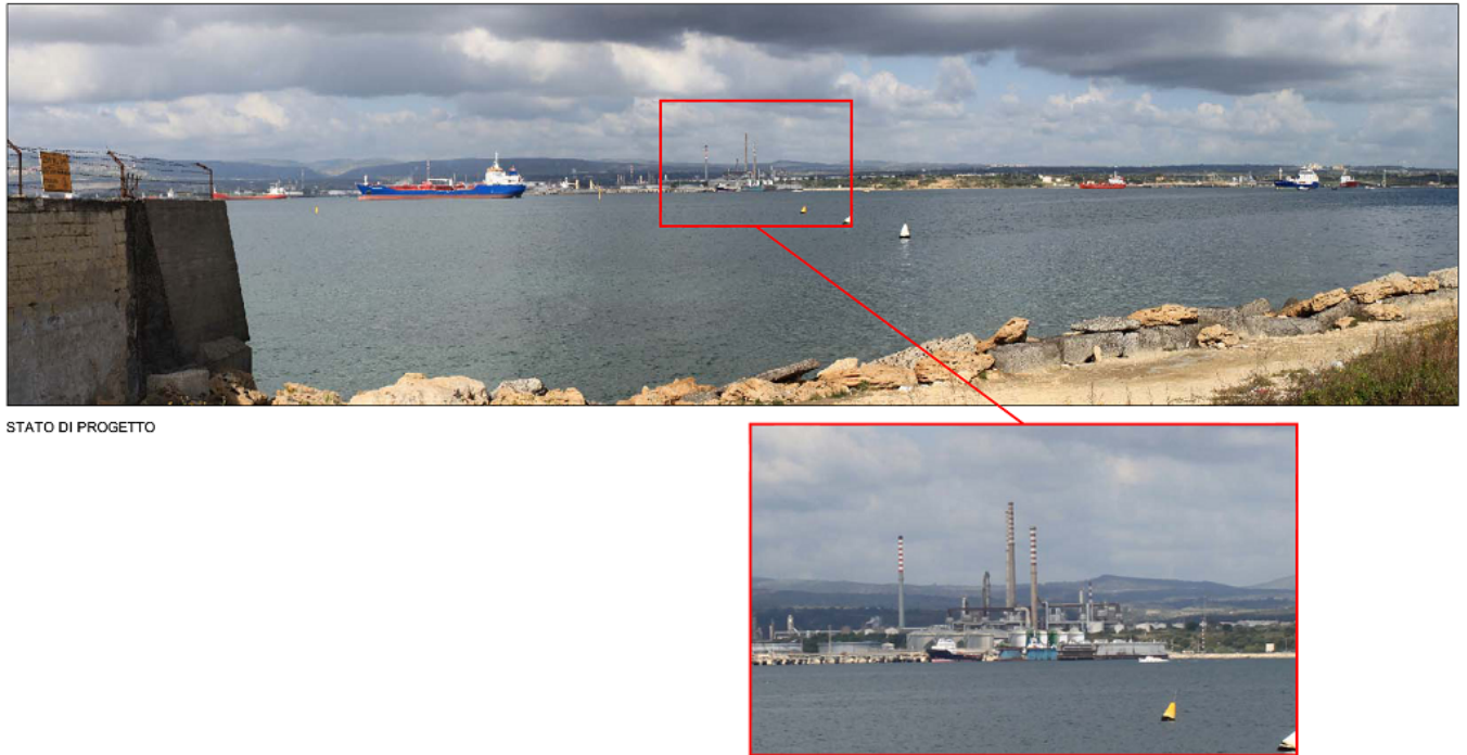
Figura 6.f: Fotoinserimento del Nuovo Deposito Costiero (Ripresa da Augusta)
