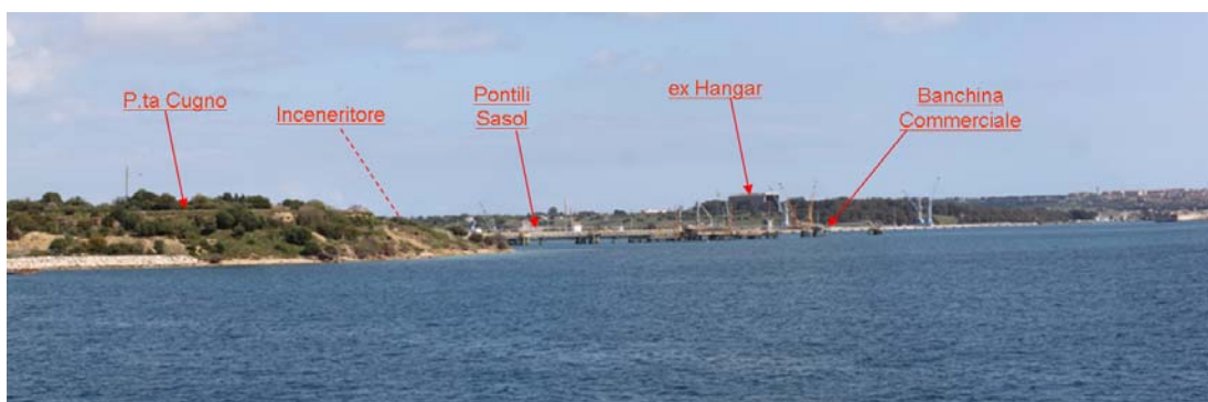
Figura 5.b: Vista verso Nord ripresa dal Pontile Consortile
