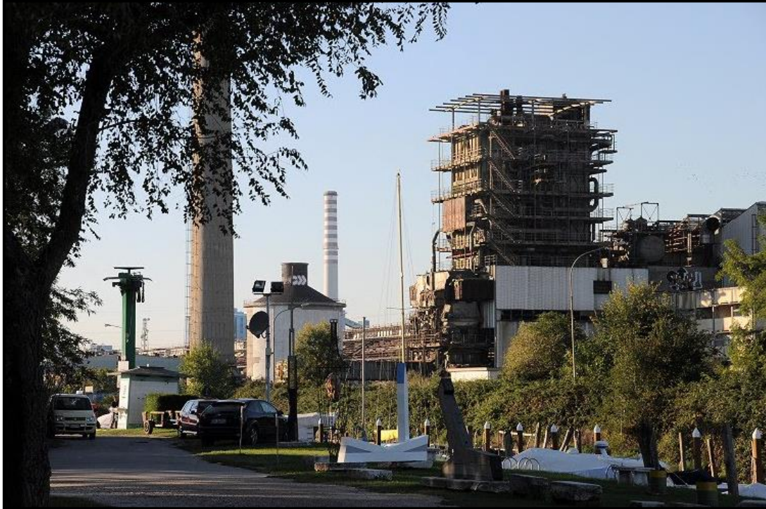
Figura 4.1.2.3c Rive del Naviglio Brenta, località Fusina (PV2)
