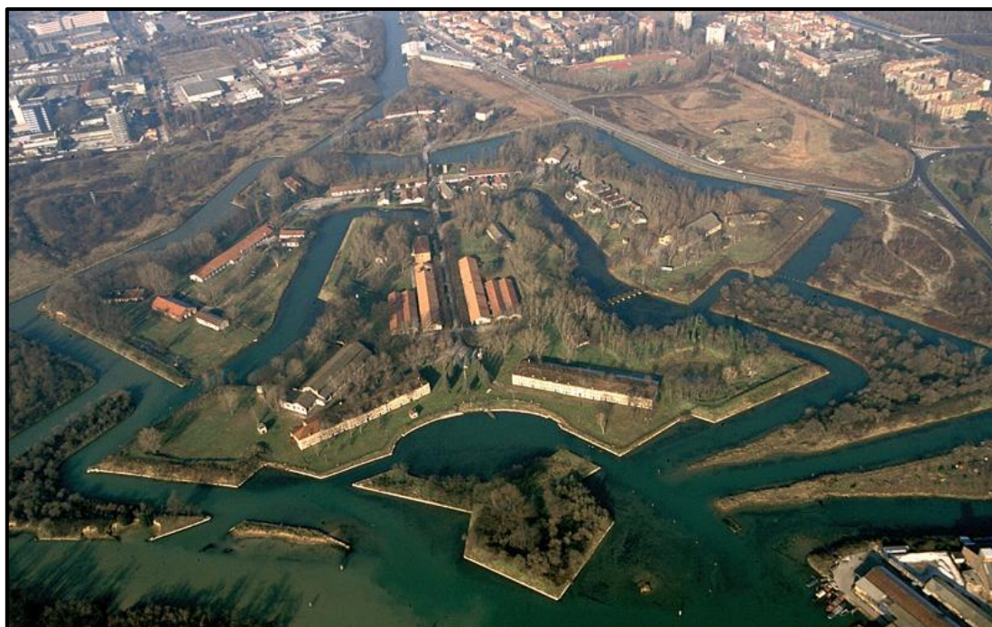
Figura 2.1.4f Vista a volo d'uccello del Forte Marghera
