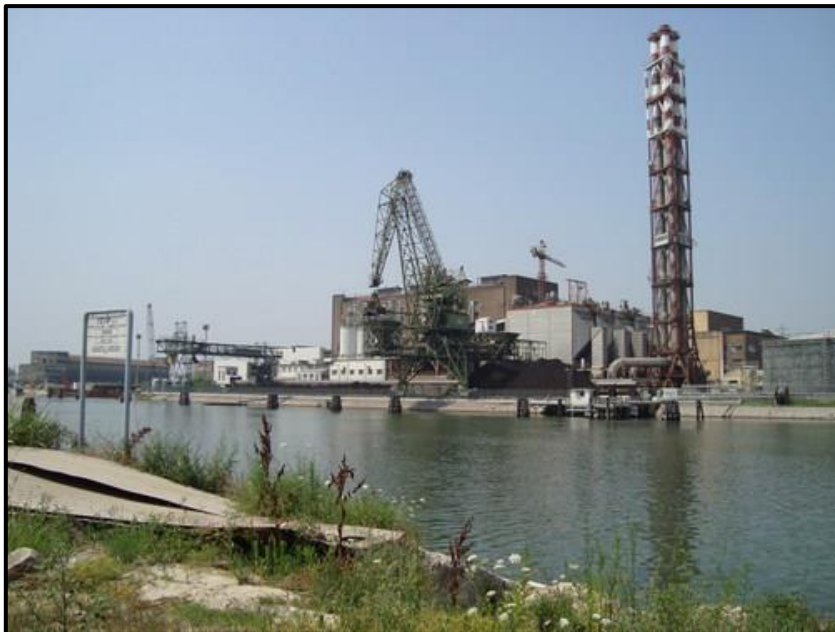
Figura 2.1.4d Canale industriale Ovest
