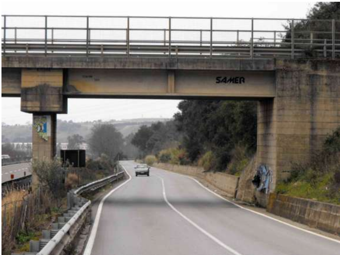
Foto 33. Cavalcavia dello svincolo di inversione sulla SP 170/2
