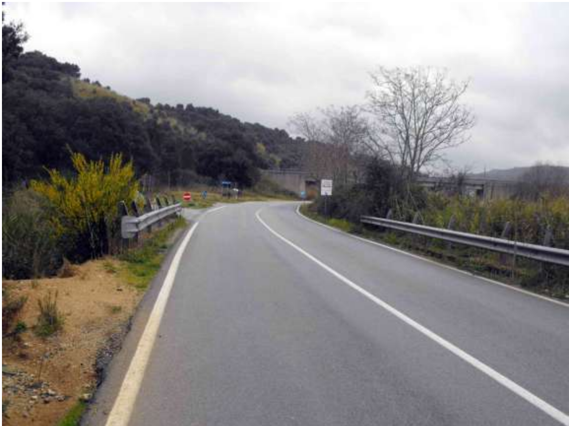
Foto 9. S.P. 170/2 nella zona di attraversamento (vista in direzione di Catanzaro)
