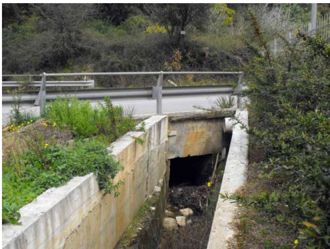
Foto 28. Interferenza N.12: tombino scatolare (particolare prospetto sud)
