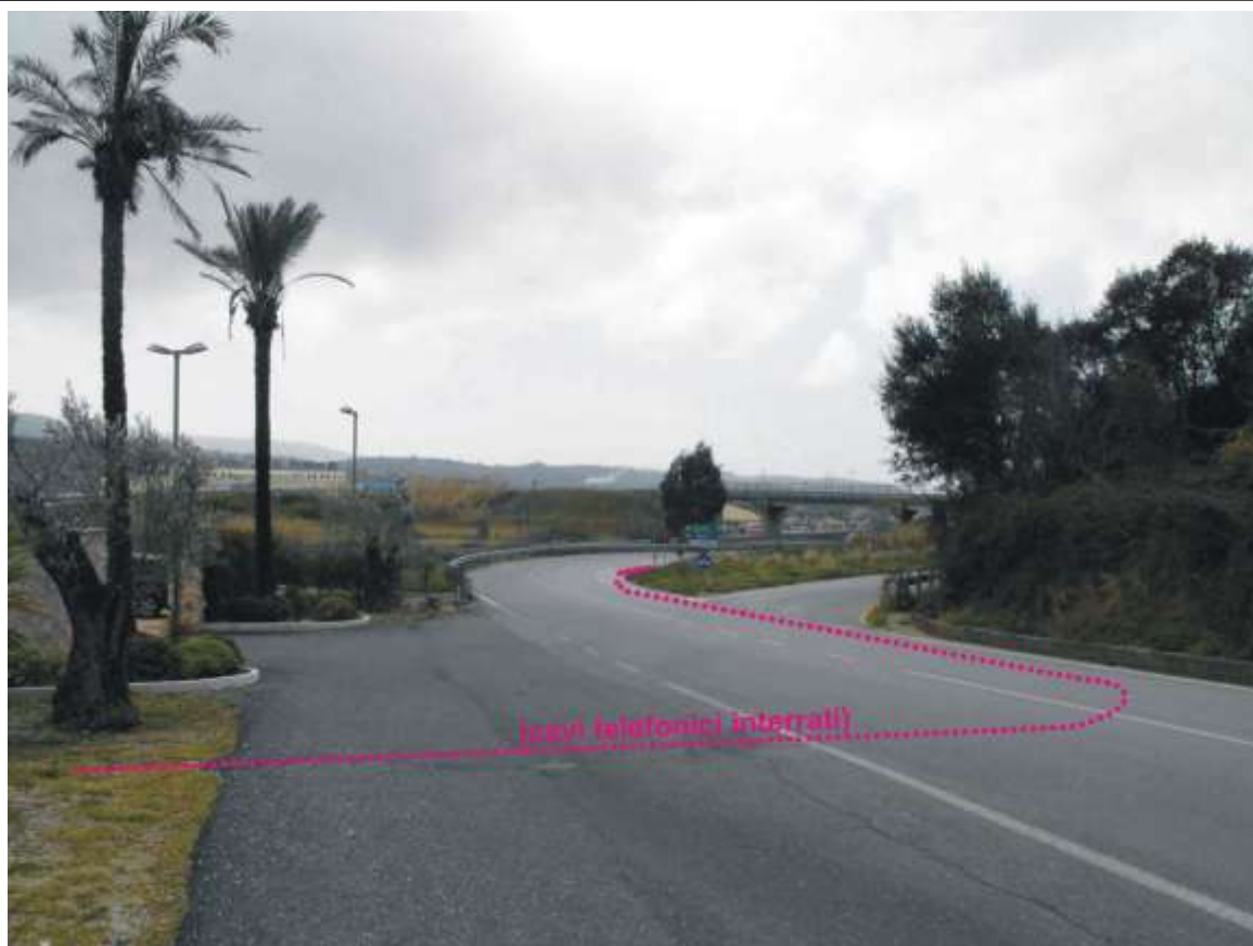
Foto 25. Interferenza N.11: cavi telefonici interrati, fronte ingresso "T" HOTEL
