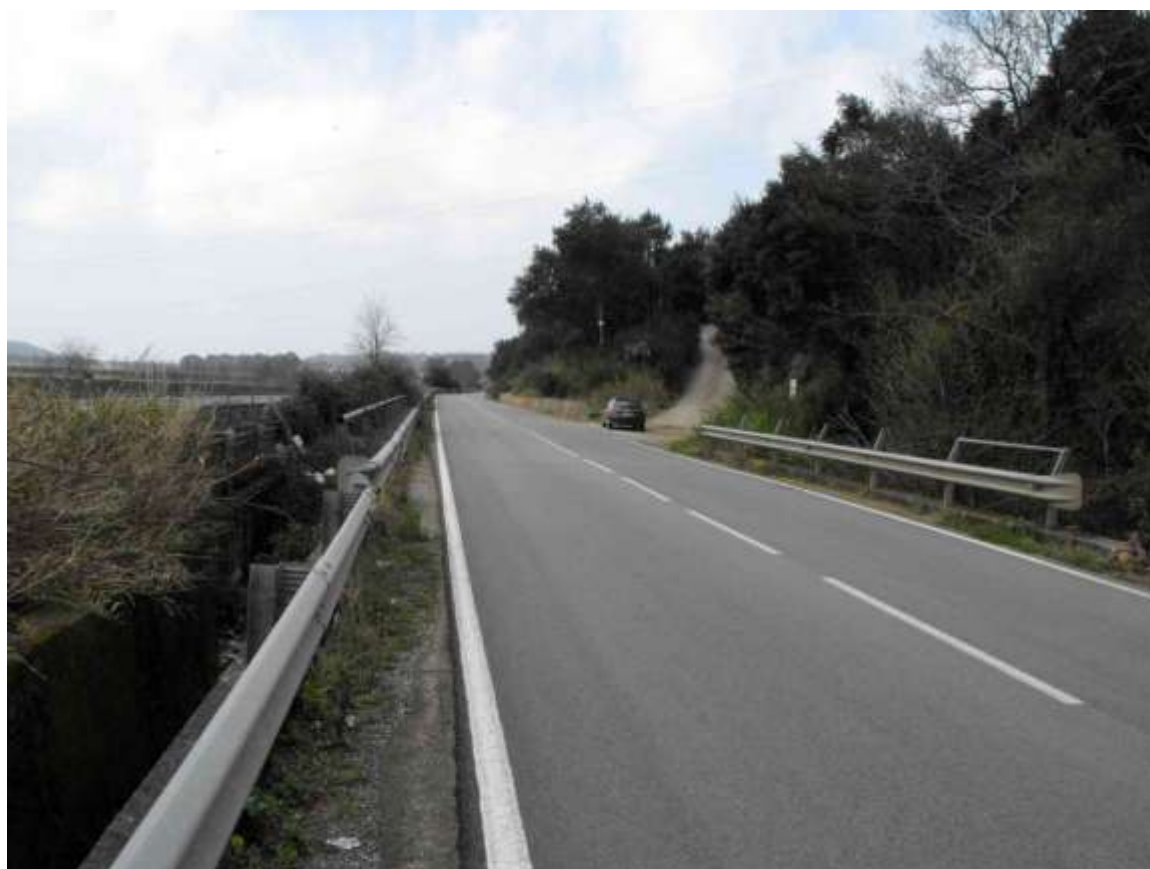
Foto 40. SP 170/2 nella zona di interferenza
