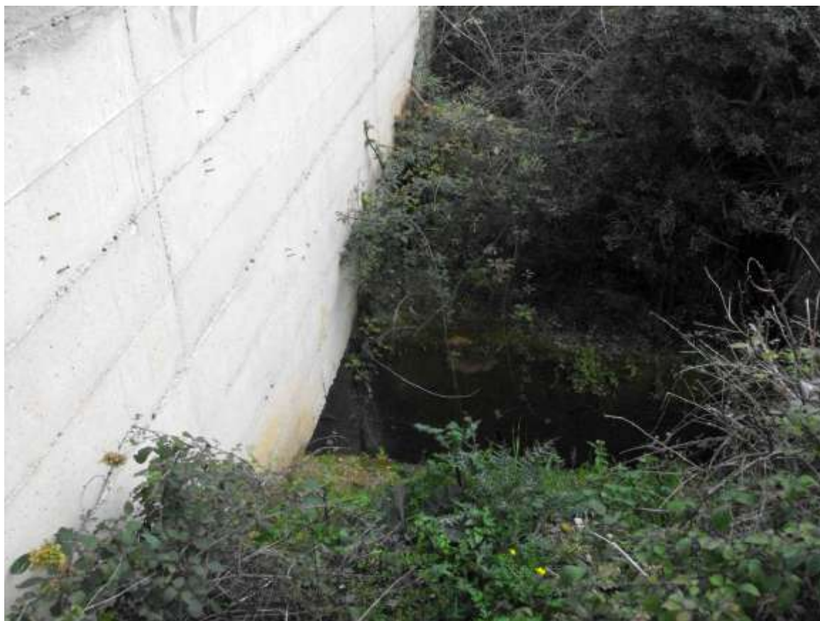
Foto 45. Interferenza N.17: tombino scatolare (lato sud)
