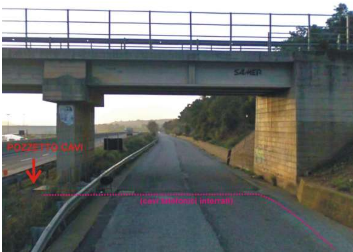
Foto 34. Interferenza N.14: cavi telefonici interrati
