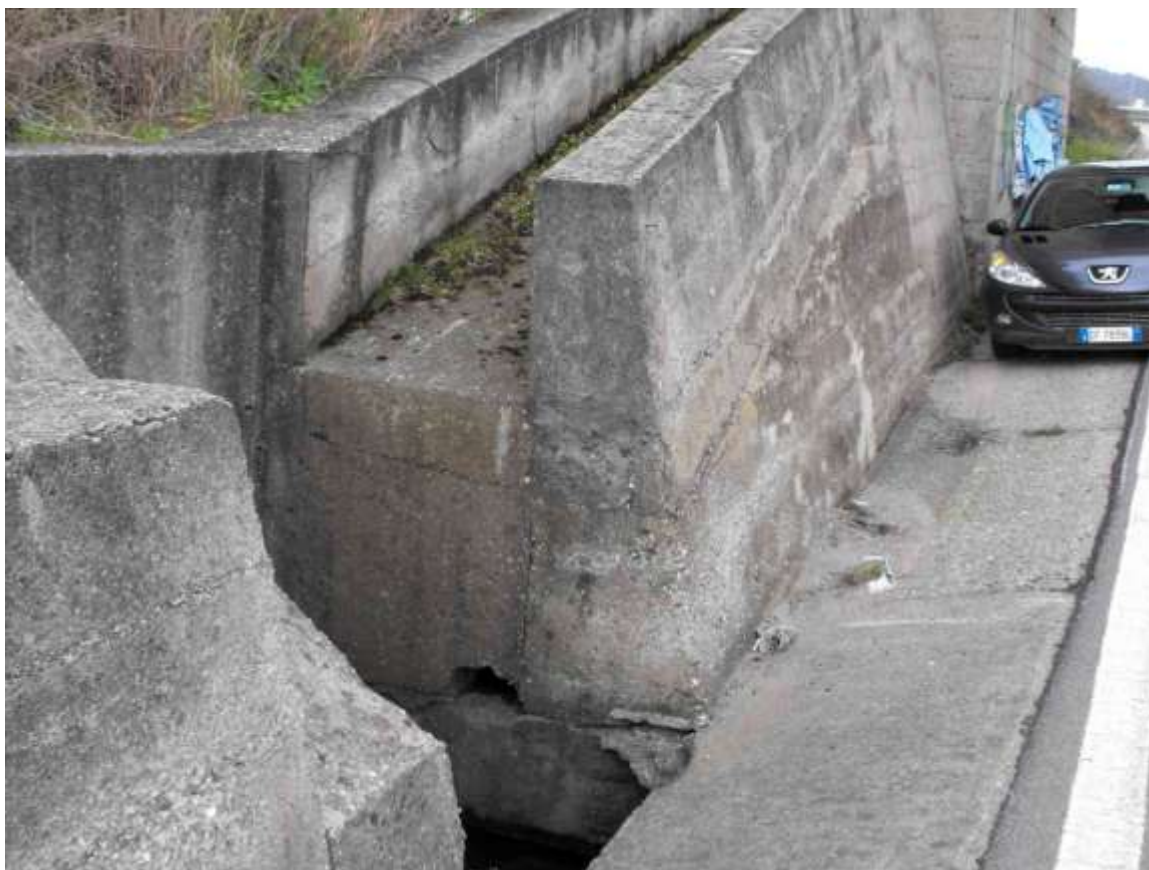
Foto 35. Interferenza N.15: doppia tubazione in c.l.s. interrata Ø 600 (lato nord)
