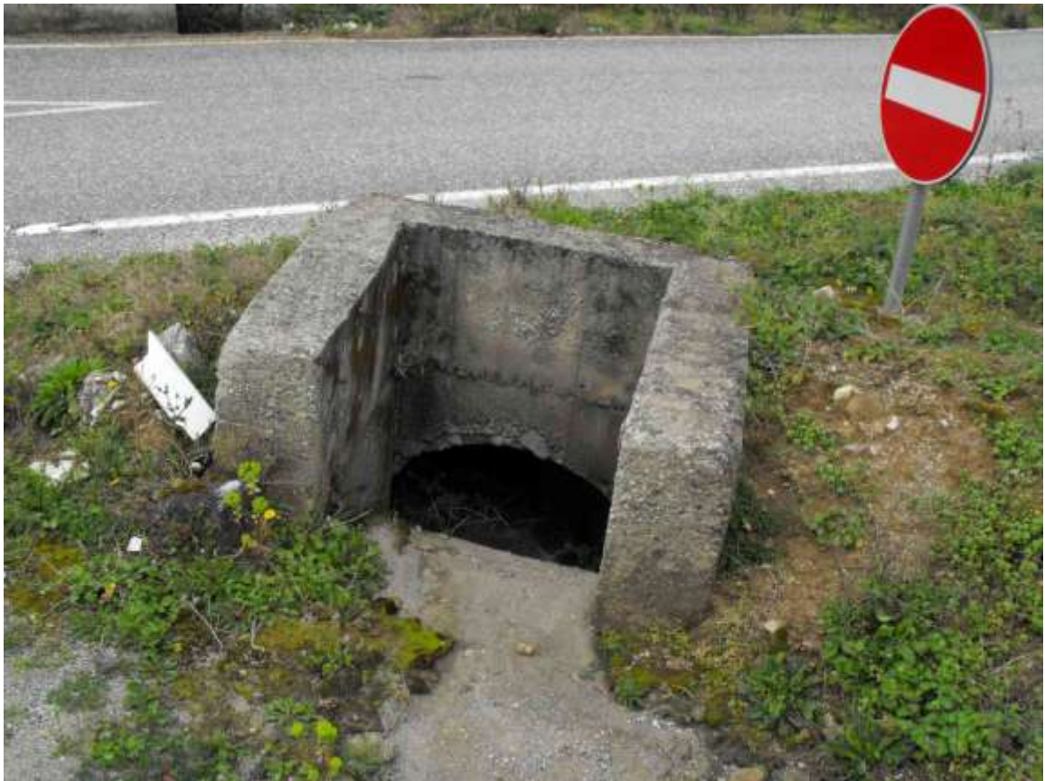
Foto 31. Interferenza N. 13: tombino tubolare in c.l.s. Ø 1000 (lato nord)
