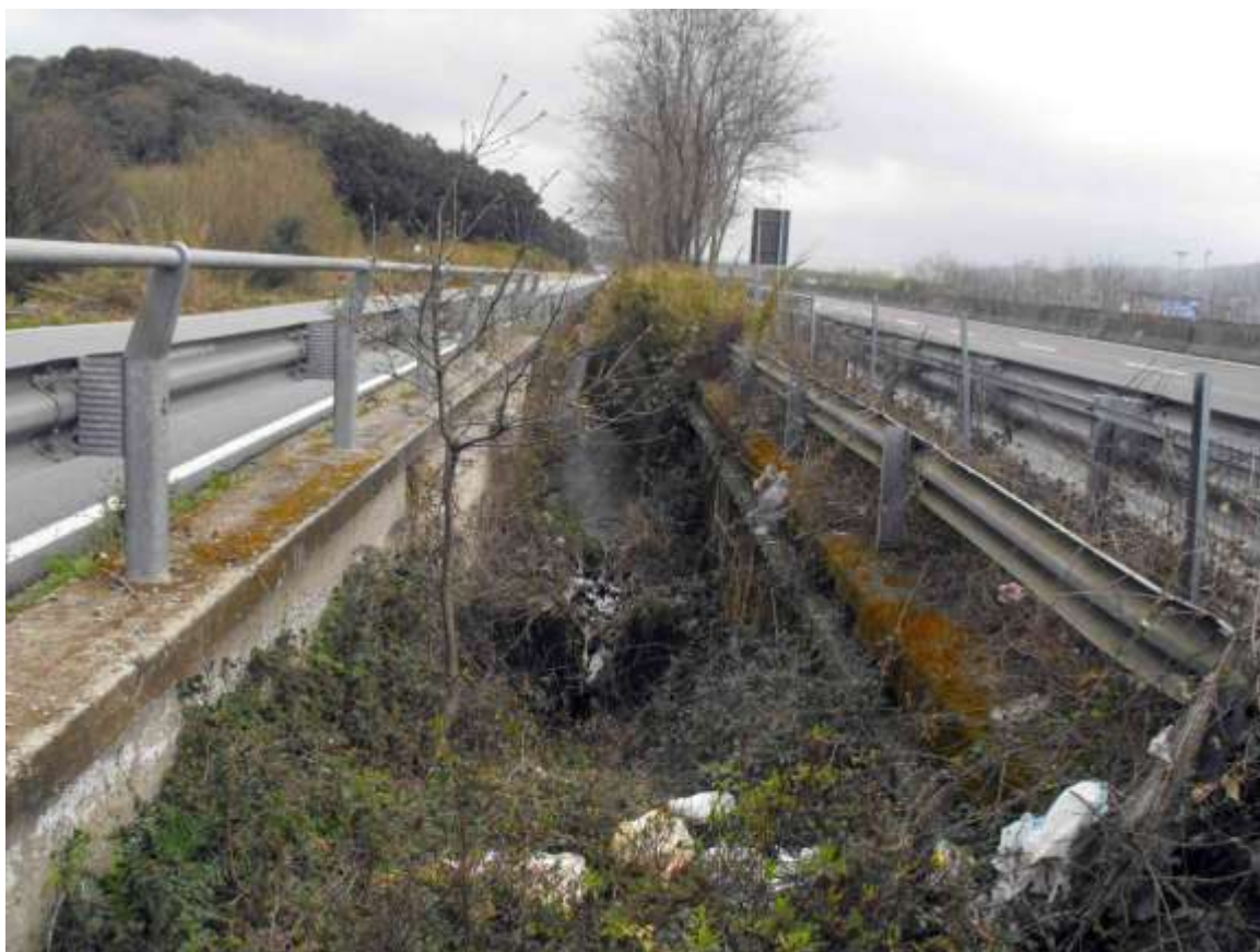
Foto 39. Interferenza N.16: tombino scatolare (lato sud)
