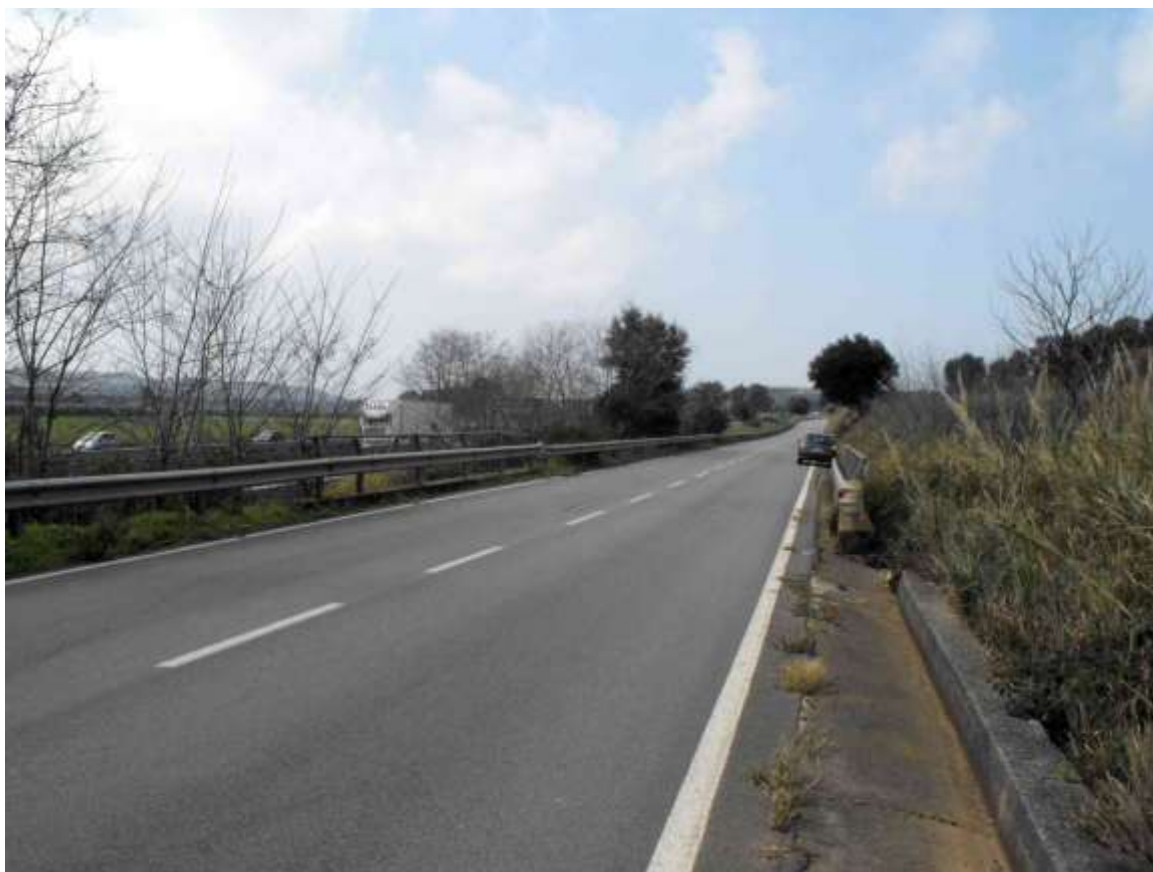
Foto 43. SP 170/2 nella zona di interferenza con il tombamento N. 17
