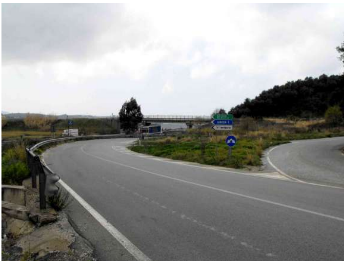
Foto 26. percorrenza sotto SP 170/2 nella zona del tombamento n.12
