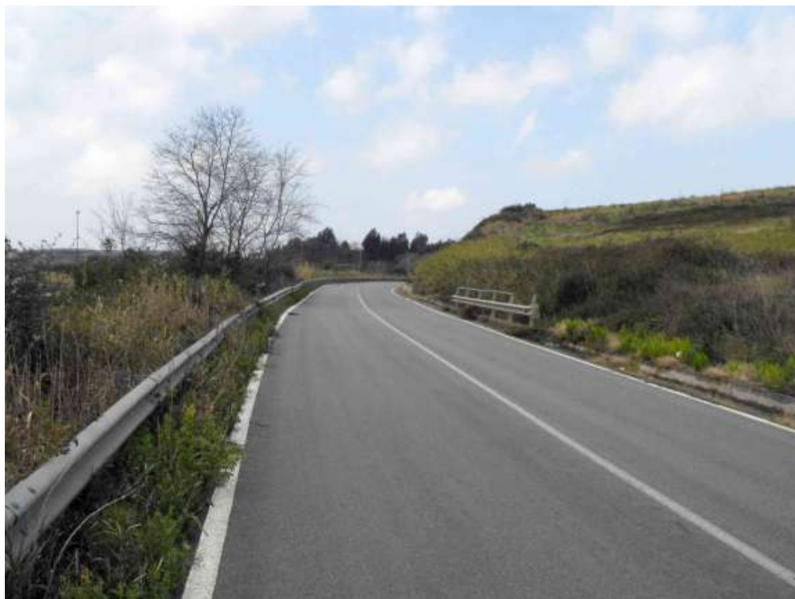
Foto 51. SP 170/2 nella zona dell'interferenza N.22
