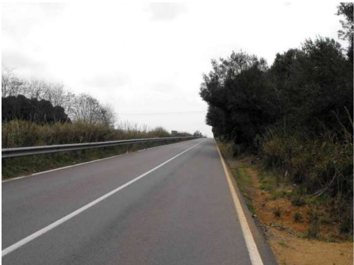
Foto 10. Inizio percorrenza sotto SP 170/2 (vista in direzione della stazione TERNA)
