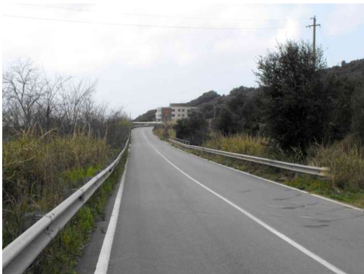
Foto 20. SP 170/2 nella zona di interferenza
