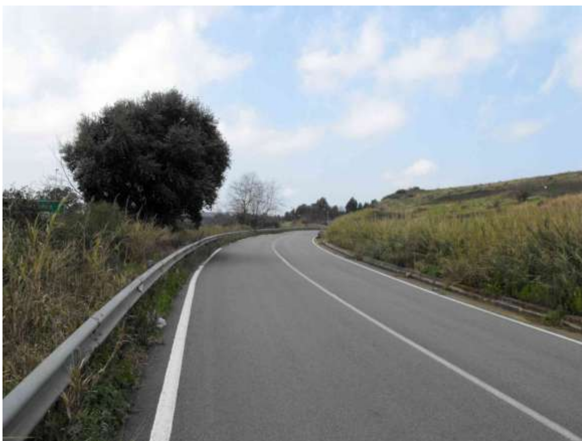
Foto 50. Strada Provinciale N.170/2
