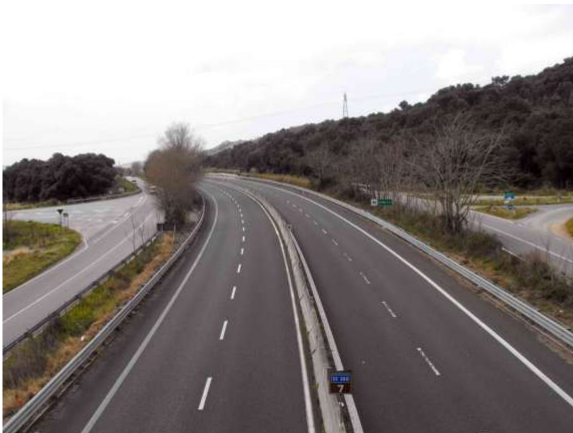
Foto 8. Interferenza con la S.S. 280 "dei due mari": panoramica dal cavalcavia
