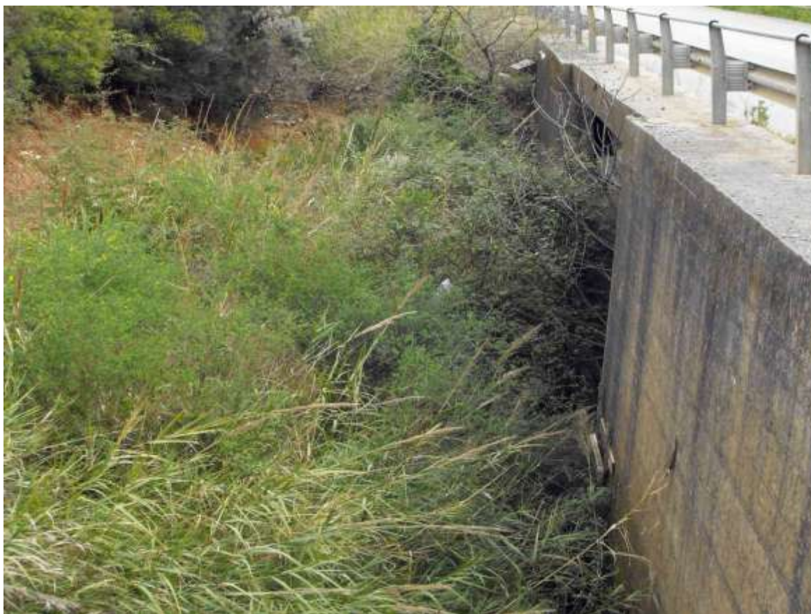
Foto 19. Interferenza n. 9 – particolare del ponticello in c.a. (prospetto nord)
