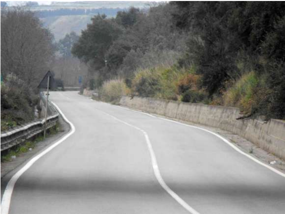
Foto 37. Percorrenza sotto la SP 170/2, dopo il cavalcavia
