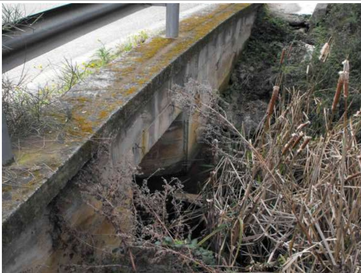
Foto 27. Interferenza N.12: tombino scatolare (particolare prospetto nord)
