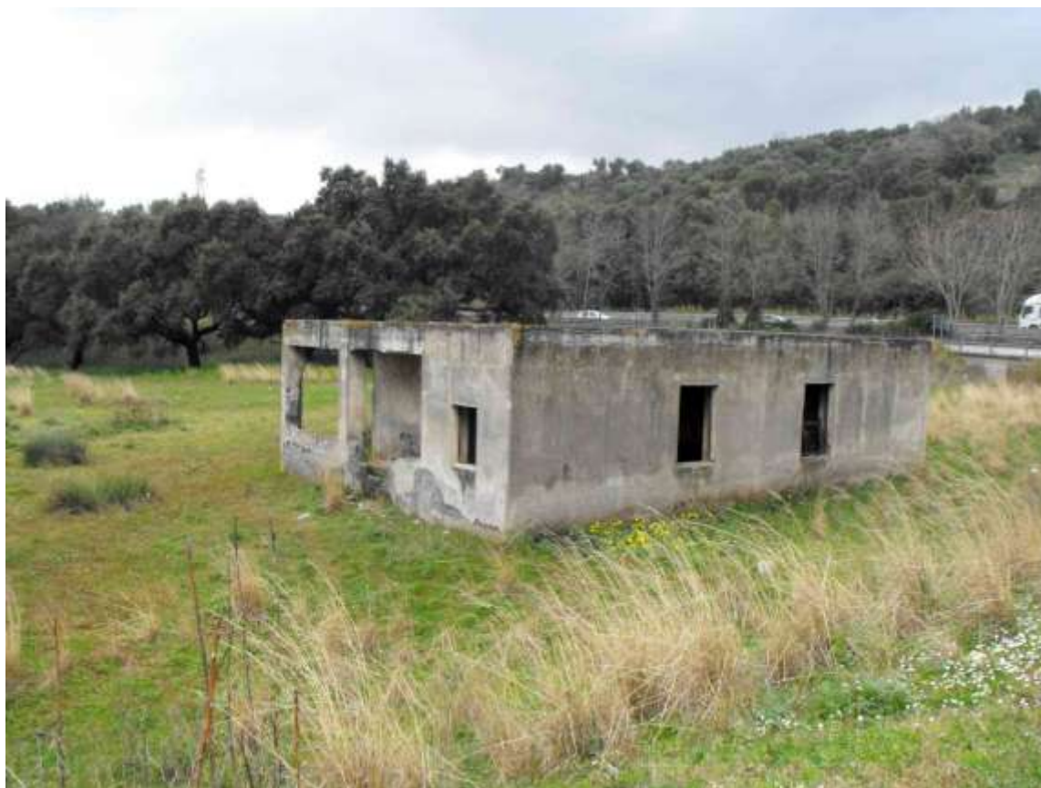
Foto 5. Edificio fatiscente ubicato a nord dell'area della centrale in progetto
