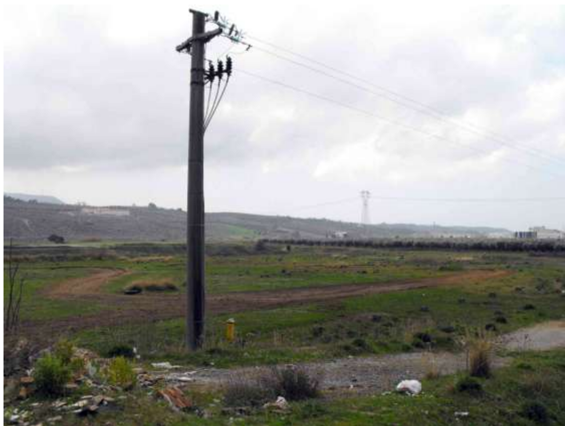
Foto 2. Panoramica del sito della centrale in progetto (parte sud)
