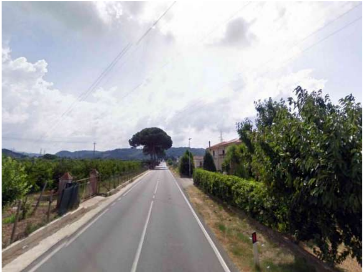
Foto 111. Strada Provinciale n° 163/2
