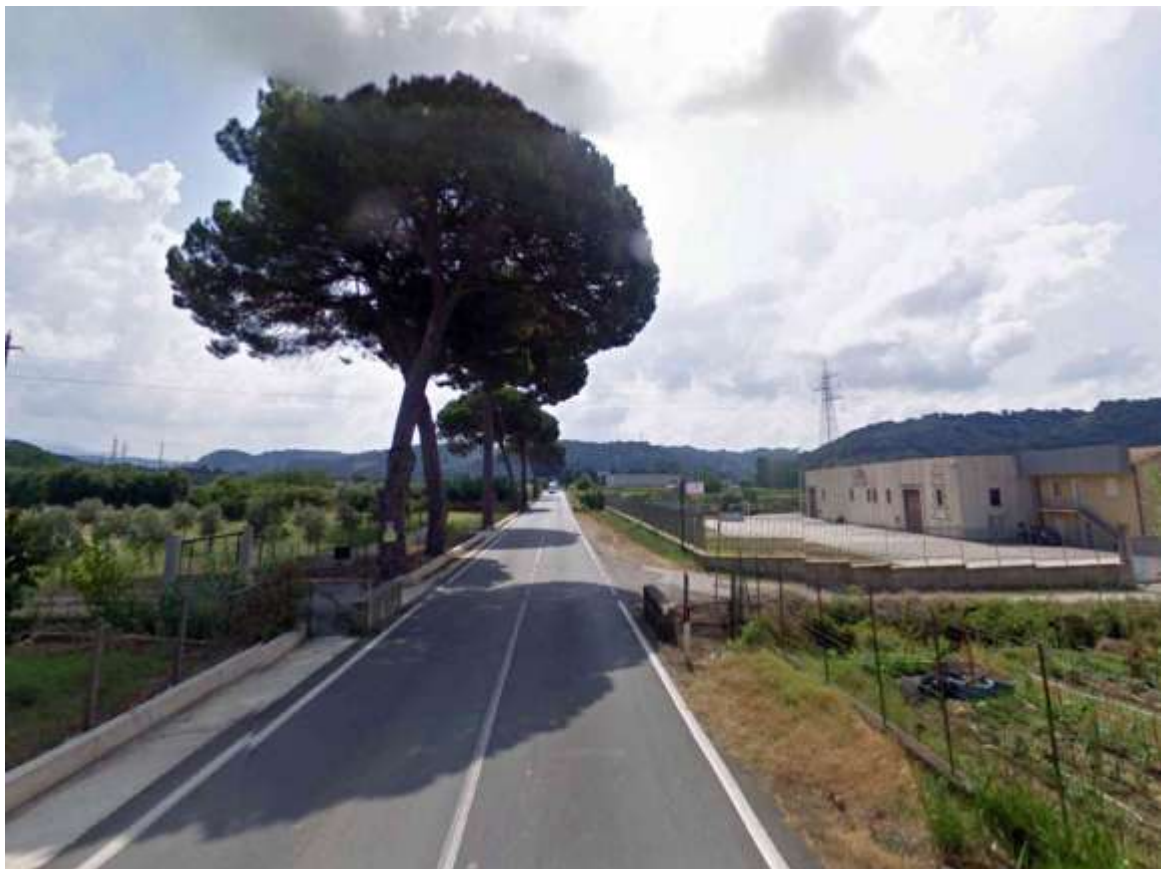
Foto 112. SP 163/2 nella zona di interferenza con il tombamento N. 39
