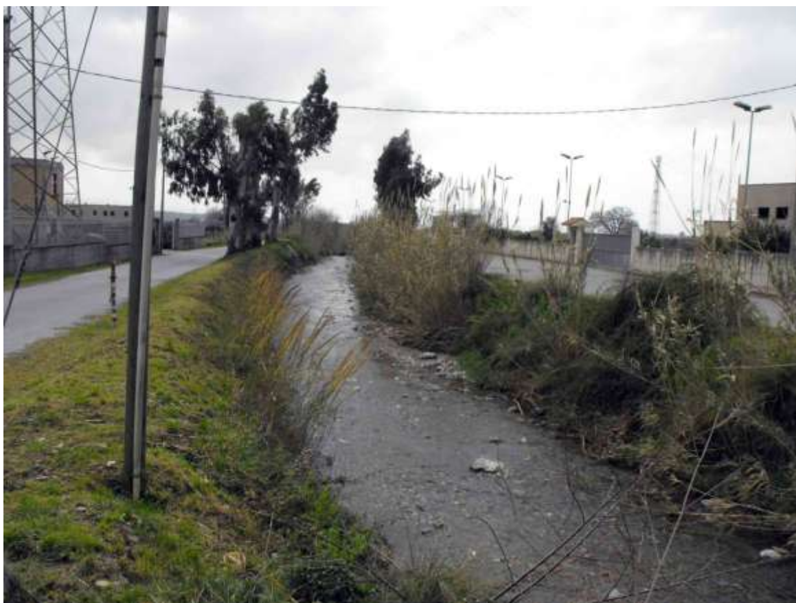
Foto 108. Torrente Cardolo: attraversamento corso d'acqua e servizi interrati
