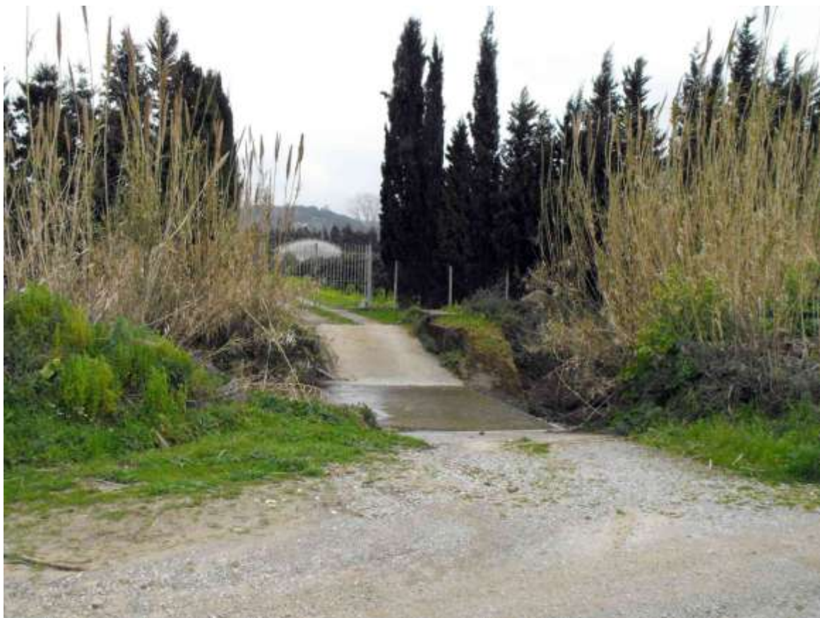
Foto 100. Guado e accesso sul torrente Cardolo, a lato della strada
