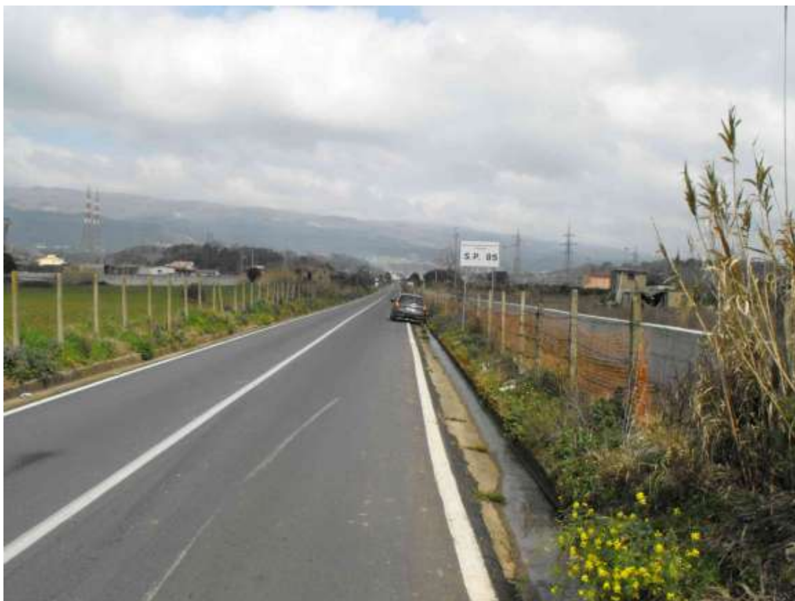
Foto 121. Tratto iniziale di percorrenza della SP 85
