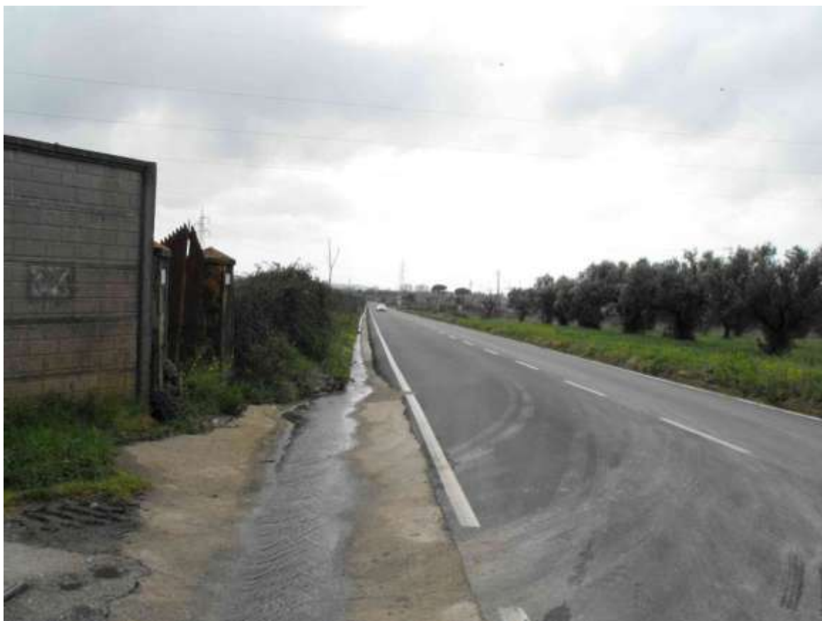
Foto 126. Spigolo recinzione della sottostazione TERNA e SP 85 vista in direzione sud
