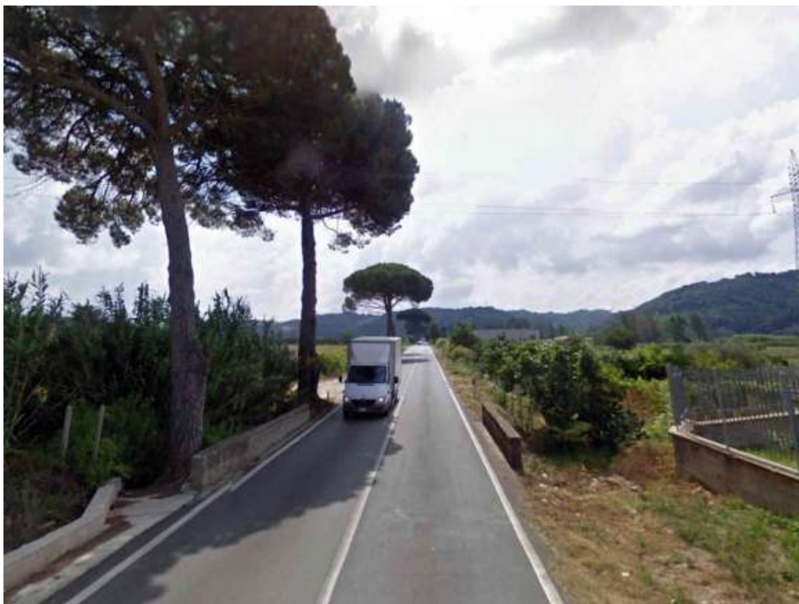
Foto 114. SP 163/2 nella zona di interferenza con il tombamento N.40
