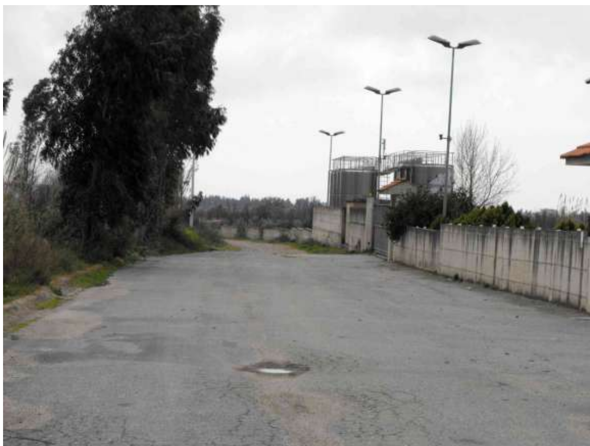
Foto 104. Ultimo tratto di percorrenza sotto strada (visto in direzione sud)
