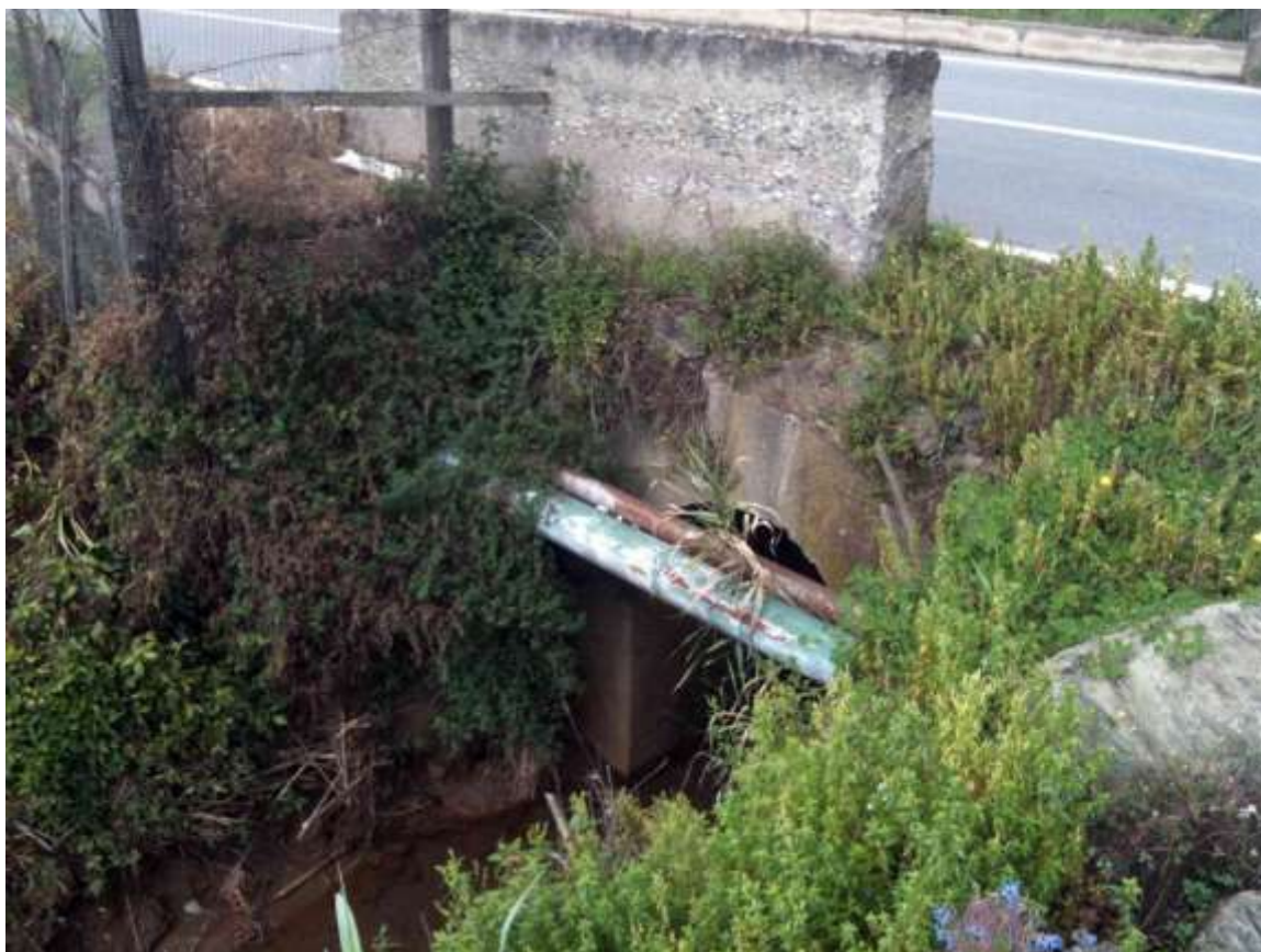
Foto 113. Tombamento N. 39 – prospetto lato sud
