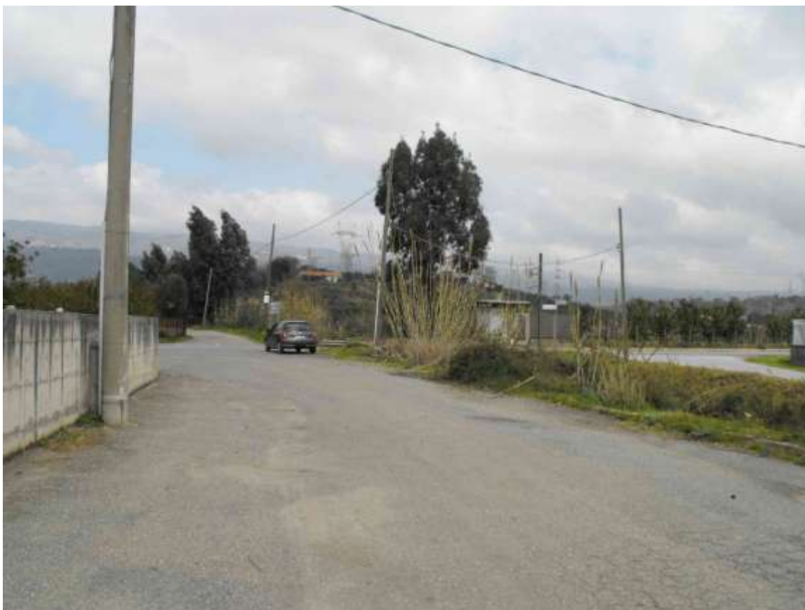
Foto 105. Ultimo tratto di percorrenza sotto strada, prima dell'attraversamento del fosso
