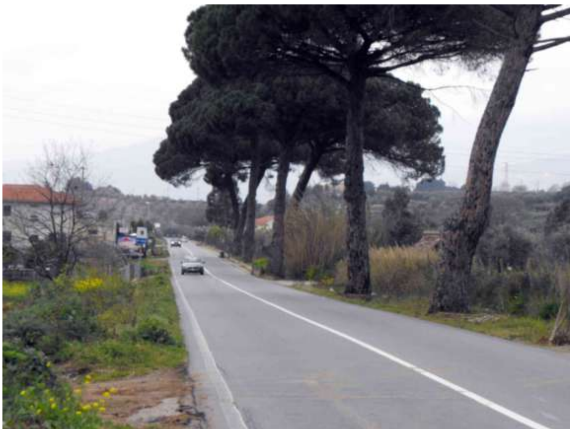
Foto 116. SP n. 163/2 vista in direzione di Lamezia
