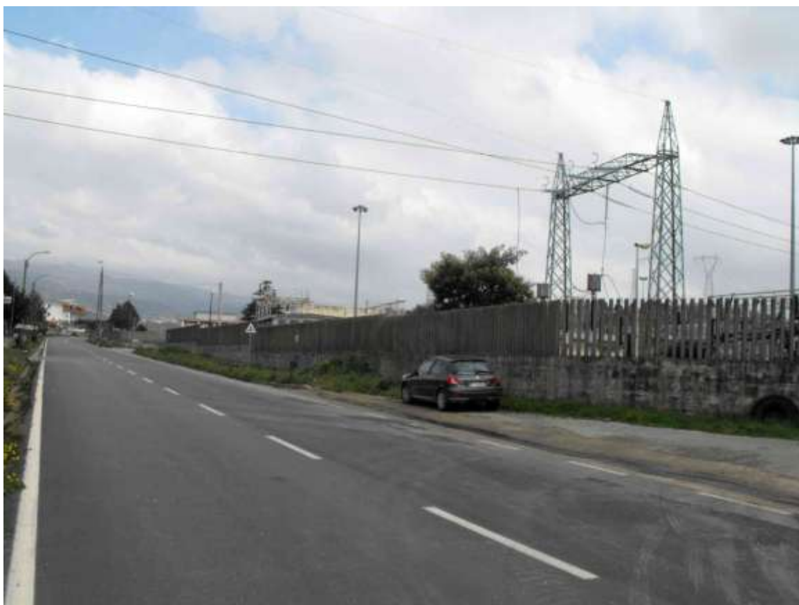
Foto 130. Portali – punto di arrivo cavidotto
