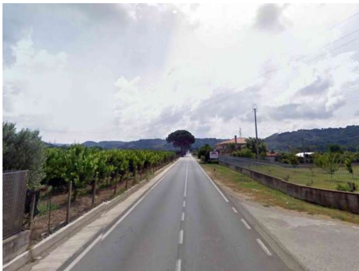
Foto 110. SP 163/2: panoramica del rettifilo dopo il torrente
