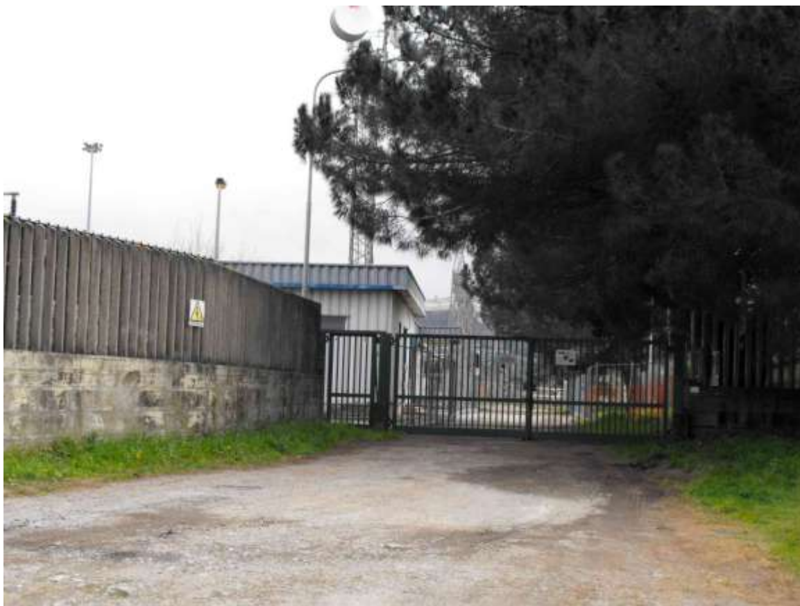
Foto 127. Ingresso carraio stazione elettrica TERNA
