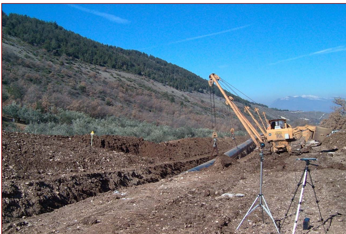
Figura 5-1 Rilievi acustici durante l'operazione di posa della condotta
