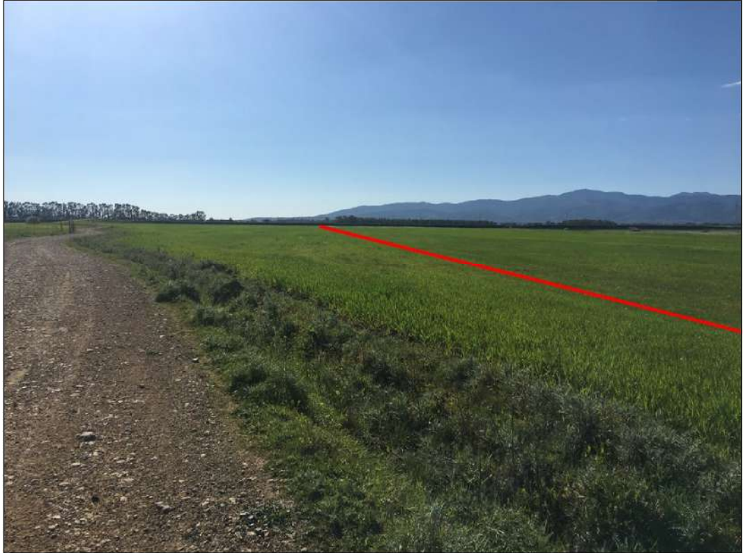
Tratto iniziale della condotta, in Comune di Vallermosa
