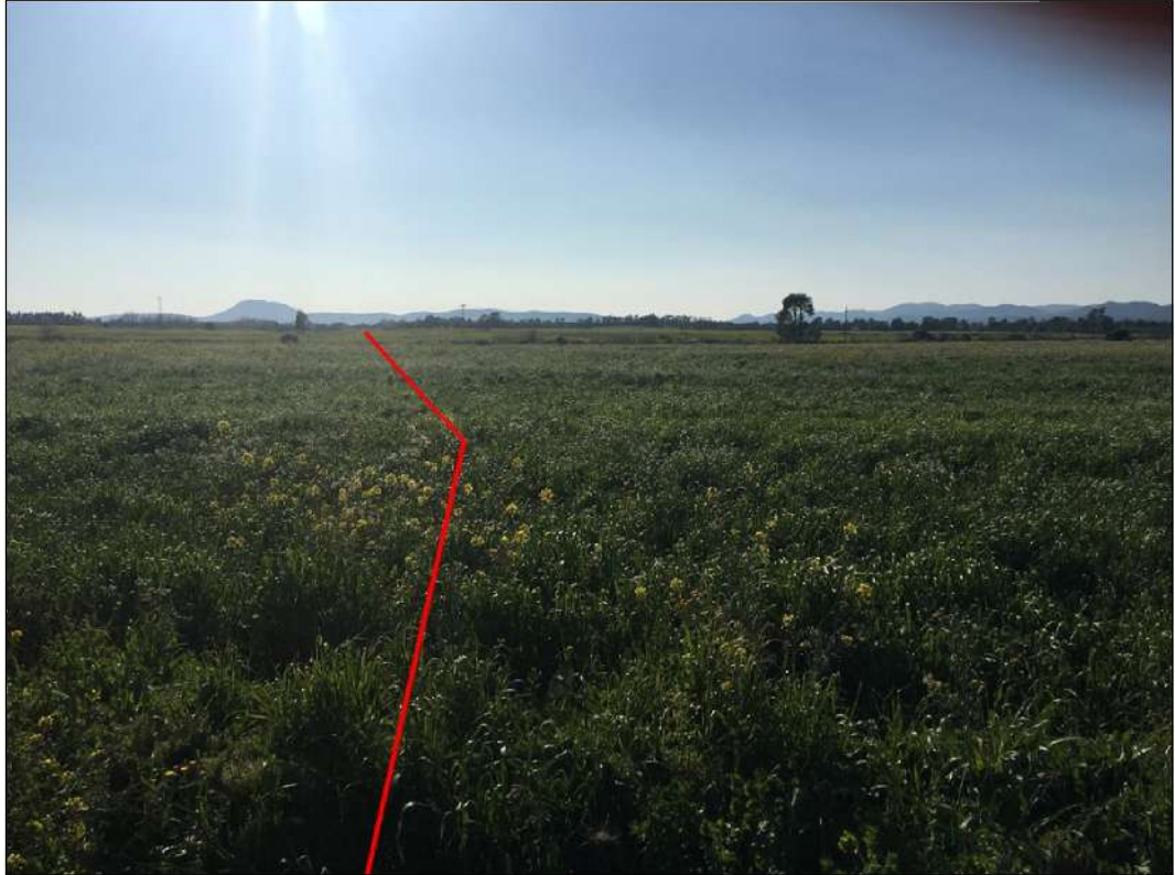
Panoramica del tracciato a nord della stazione ferroviaria di Villamassargia Domusnovas, in prossimità del Riu Pisueddu, in Comune di Villamassargia
