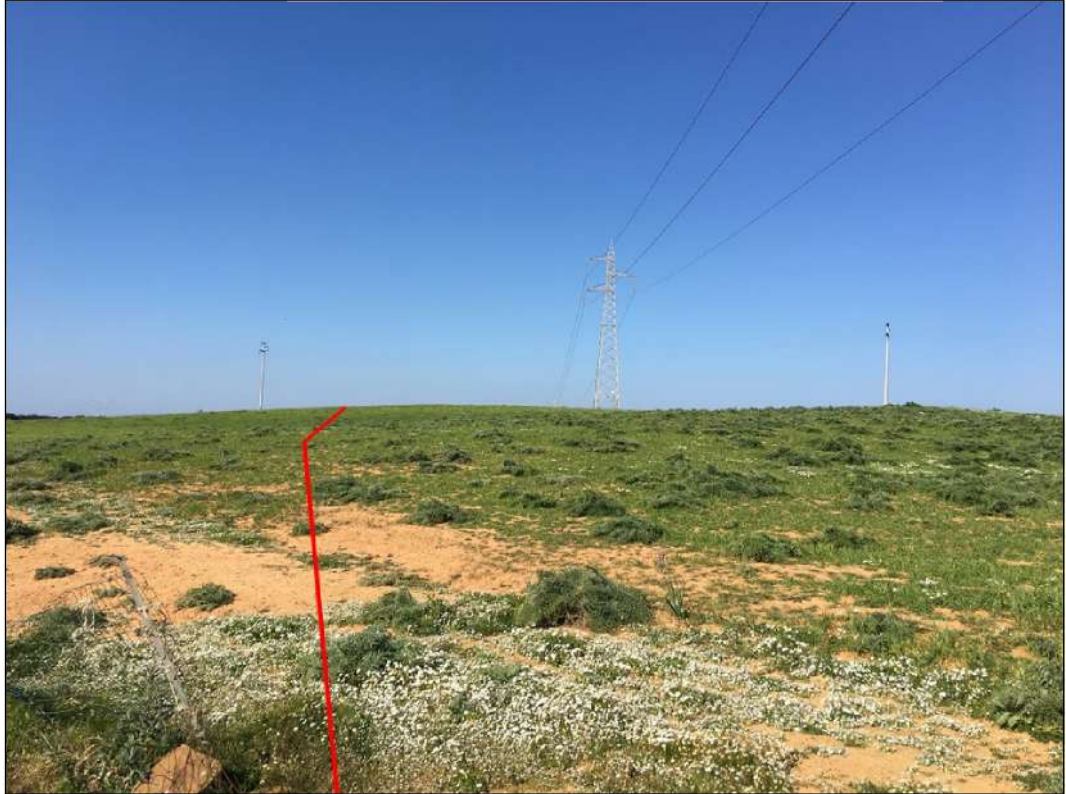
Attraversamento di prati-pascoli a nord-ovest della frazione di Corongiu, in Comune di Carbonia
