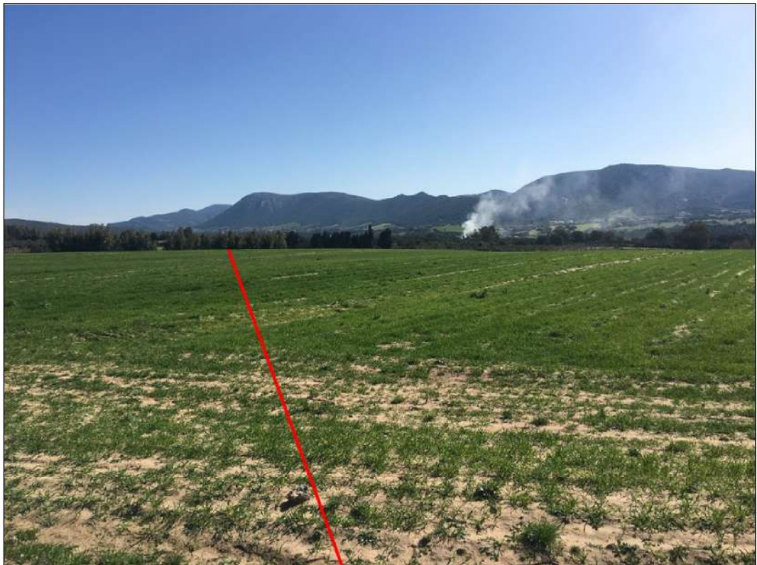
Panoramica del tracciato, in Comune di Carbonia
