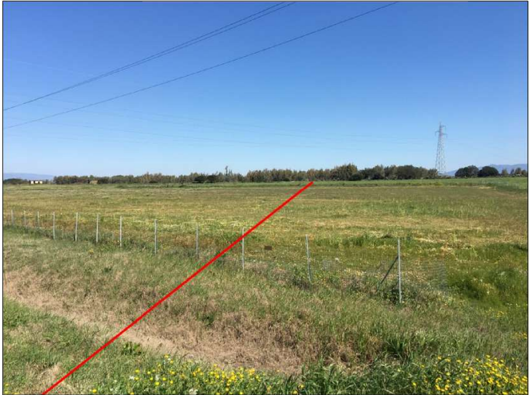
Percorrenza della condotta in prossimita' della S.S. 131 Carlo Felice, in localita' Santu Amenteddu, in Comune di Santa Giusta
