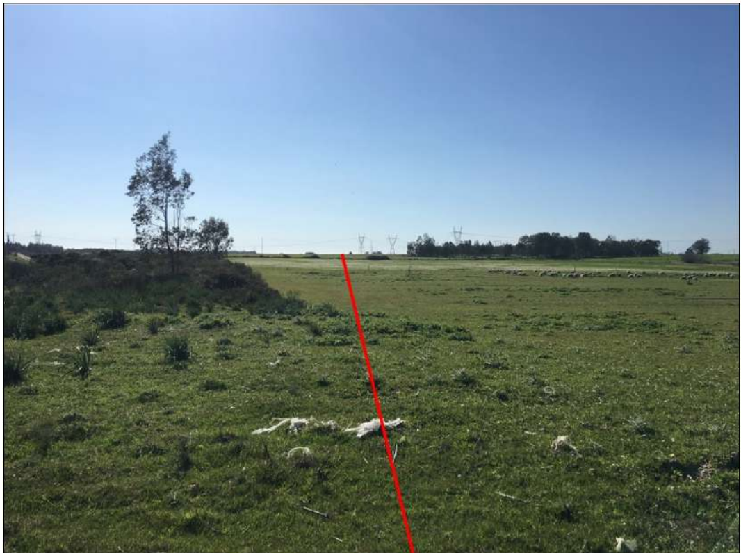
Percorrenza della condotta in terreni destinati al pascolo in prossimita' del Canale Adduttore Tirso Arborea, in Comune di Palmas Arborea
