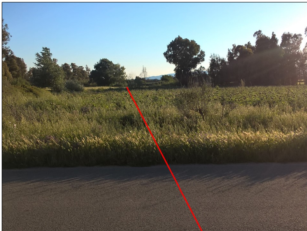
Percorrenza della condotta in prossimita' della Strada comunale di S. Giorgio, a nord ovest del centro abitato di Serramanna
