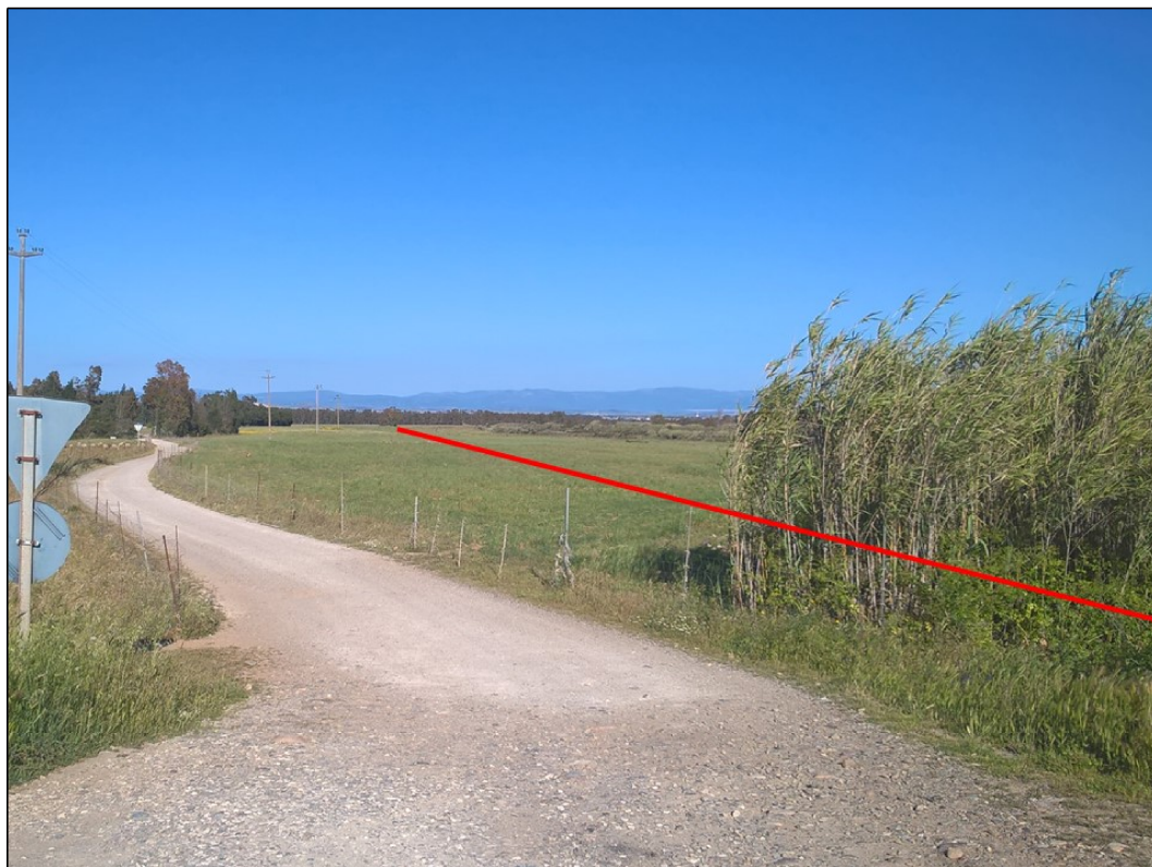
Percorrenza della condotta in prossimità della S.S. n. 293 di Giba, in Comune di Serramanna
