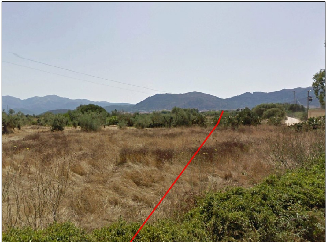
Panoramica del tratto terminale della condotta, in Comune di Guspini
