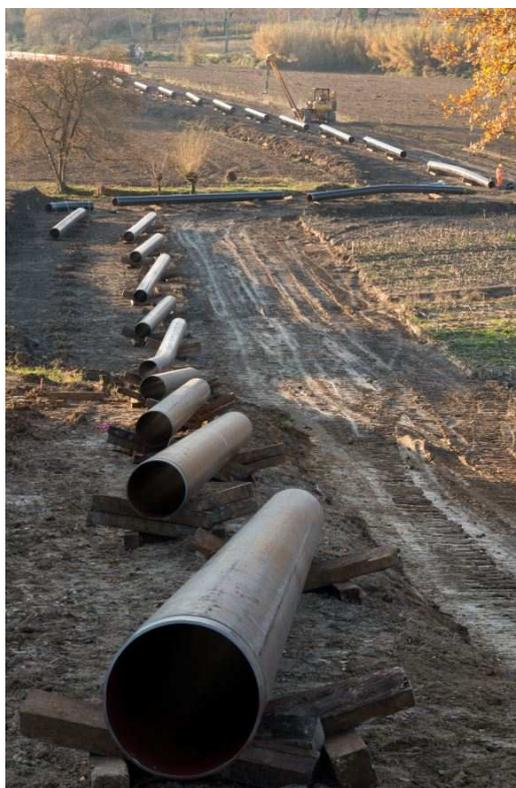
**Figura 3.c: Foto delle Tipiche Operazioni di Sfilamento tubazioni**
