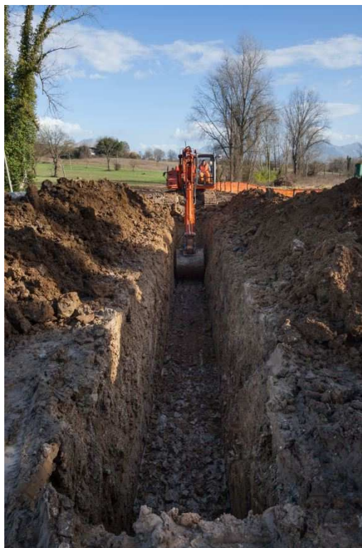
Figura 3.d: Foto delle Tipiche Operazioni di Scavo della Trincea
