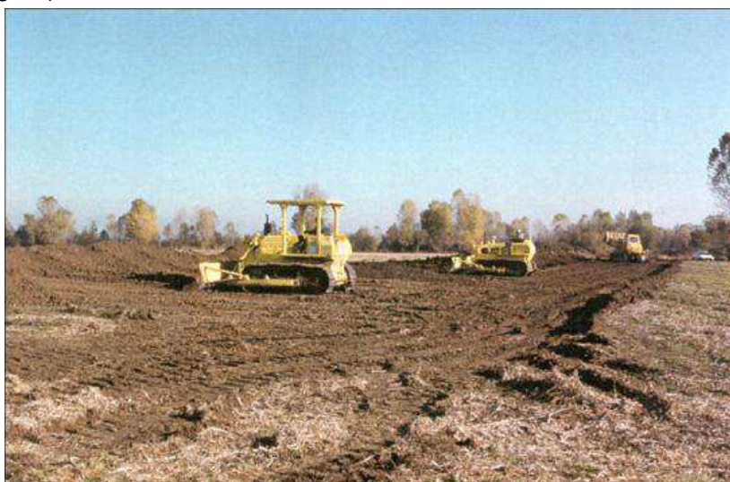
Figura 3.b: Operazioni Tipiche di Apertura dell'Area di Passaggio
