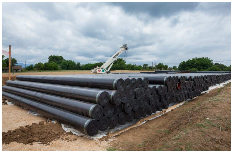
Figura 3.a: Foto Tipica di una Piazzola per Accatamento Tubazioni
