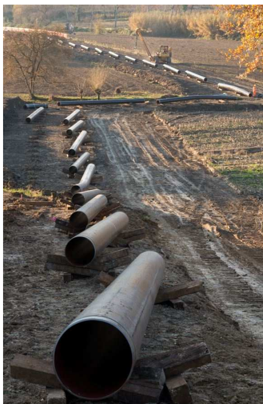
Figura 3.c: Foto delle Tipiche Operazioni di Sfilamento tubazioni
