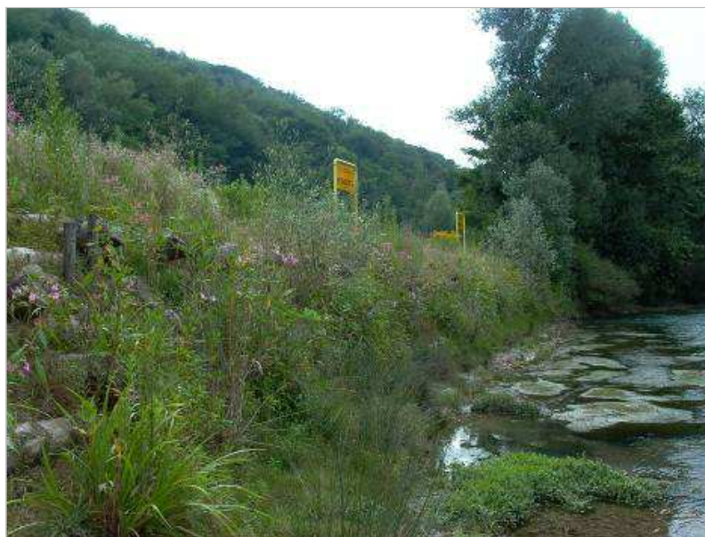
Figura 3.i: Esempio di Riprofilatura con Palizzate in legname e Ripristino vegetazionale
