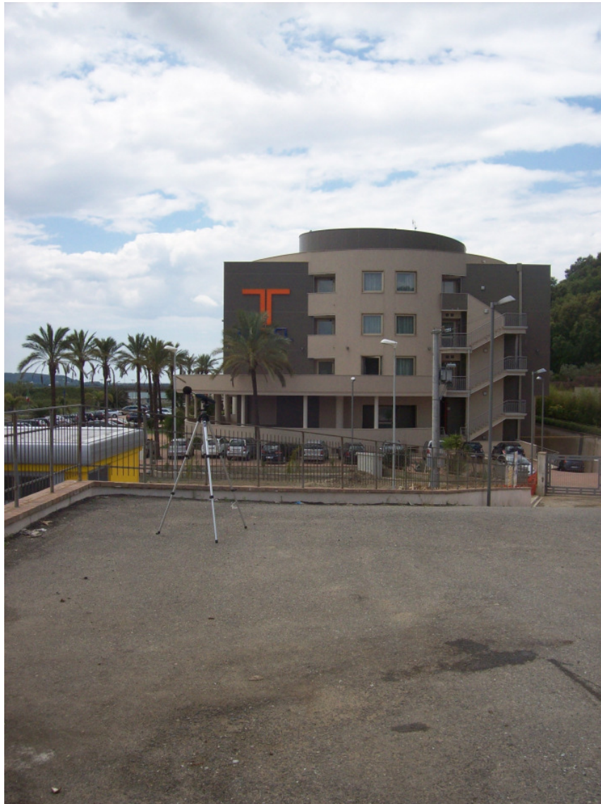
Figura 1 Foto Postazione di Misura P1
