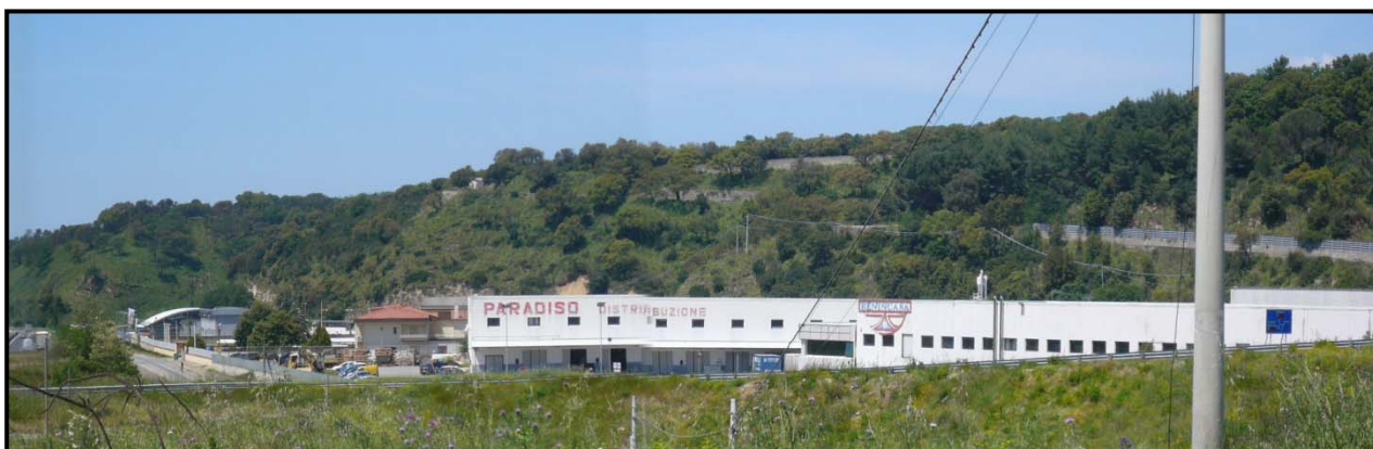
Figura 4.2.3.5e Centro Commerciale presso Ponte Calderaro
