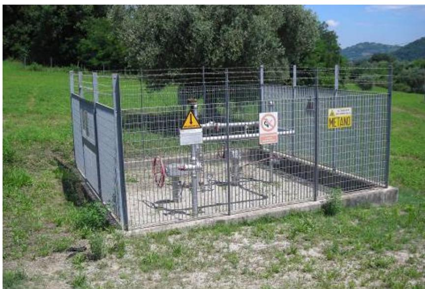
**Figura 8.I** – Esempi di Punto di Intercettazione di Linea (PIL)
