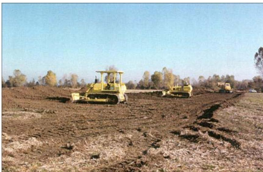
**Figura 8.B – Apertura dell'Area di Passaggio**
