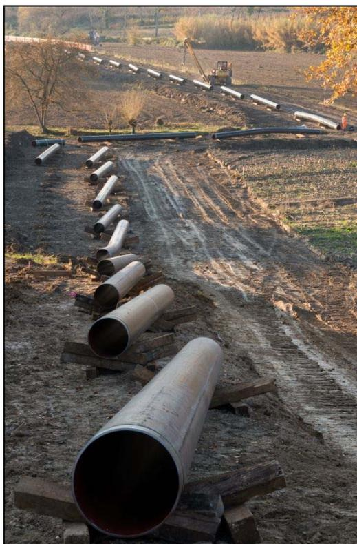
**Figura 8.C** – Sfilamento Tubi
