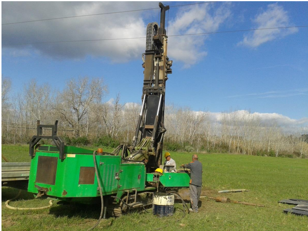
Figura 3.1: Indagine geognostica (sondaggio S1)
