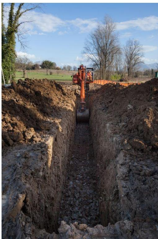
**Figura 2.d: Foto delle Tipiche Operazioni di Scavo della Trincea**
