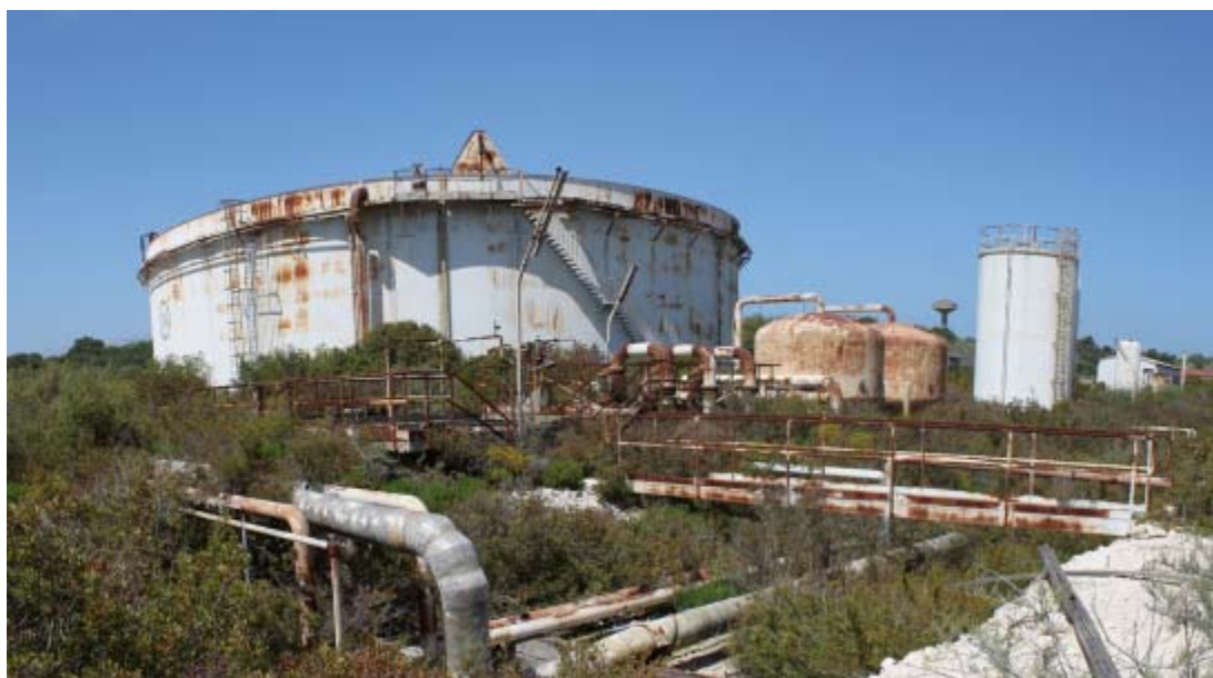
Figura 3.e: Stato di Fatto Area di Prevista Realizzazione del Deposito Costiero (Vista da Sud)
