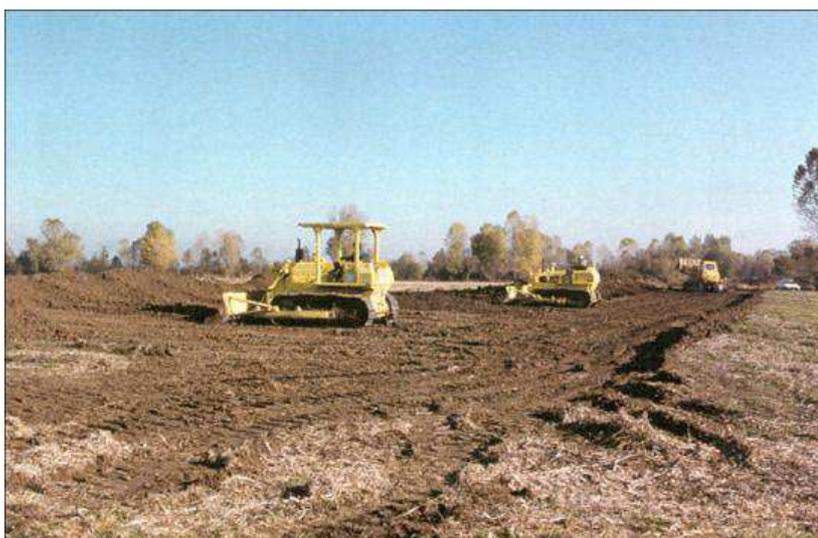
**Figura 2.b: Operazioni Tipiche di Apertura dell'Area di Passaggio**
