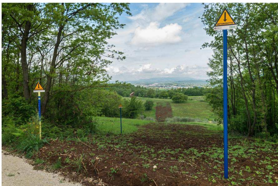
**Figura 2.i: Esempio di Ripristino in Aree Agricole**
