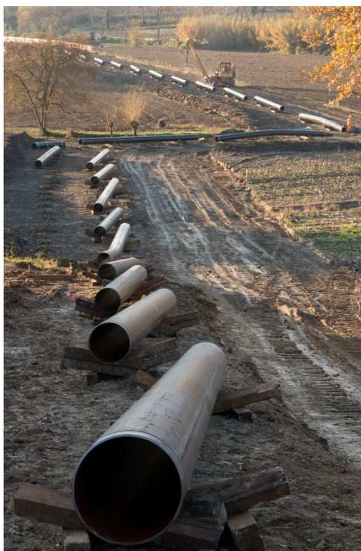
**Figura 2.c: Foto delle Tipiche Operazioni di Sfilamento tubazioni**
