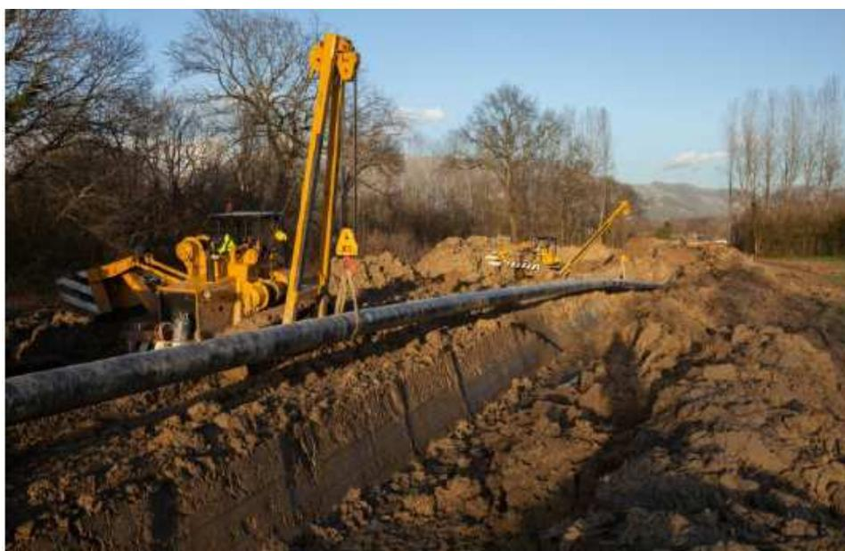
**Figura 4.f: Foto delle Tipiche Operazioni di Posa della Condotta**
