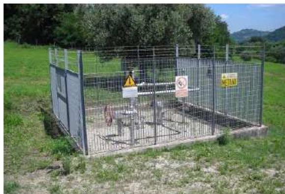
**Figura 4.h: Esempi di Punti di Intercettazione di Linea (PIL)**
