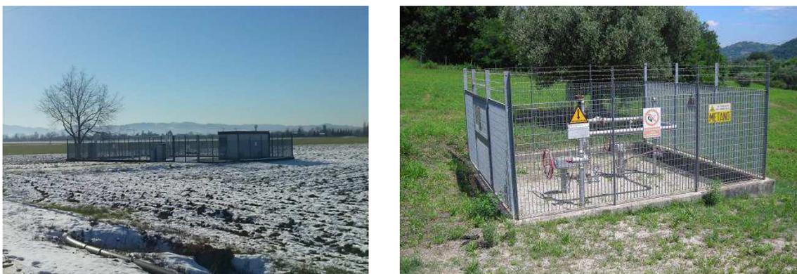
**Figura 3.f: Esempi di Punti di Intercettazione di Linea (PIL)**
