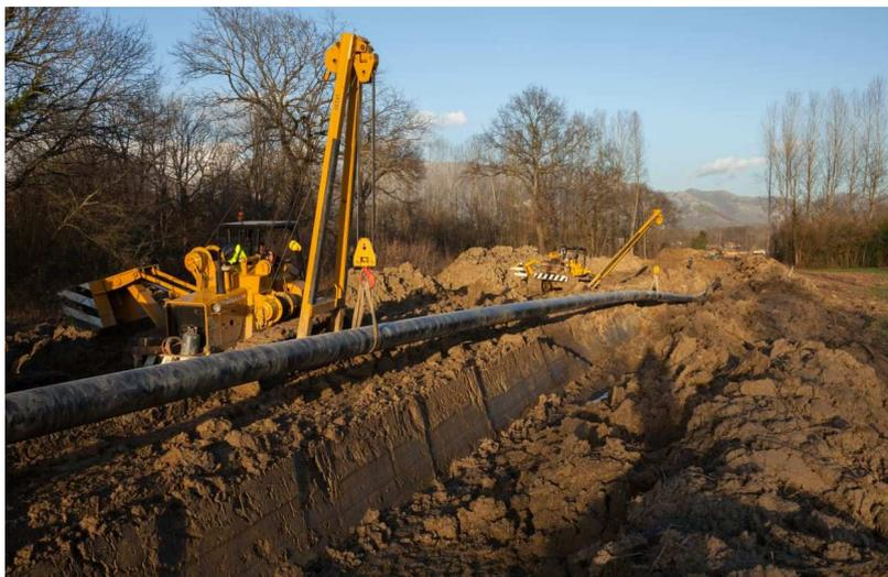
**Figura 3.e: Foto delle Tipiche Operazioni di Posa della Condotta**
