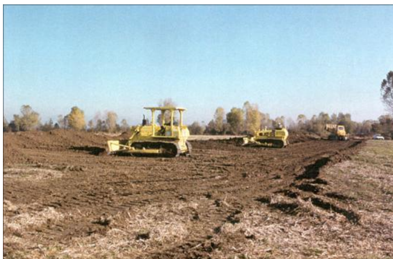
Figura 5.b: Operazioni Tipiche di Apertura dell'Area di Passaggio
