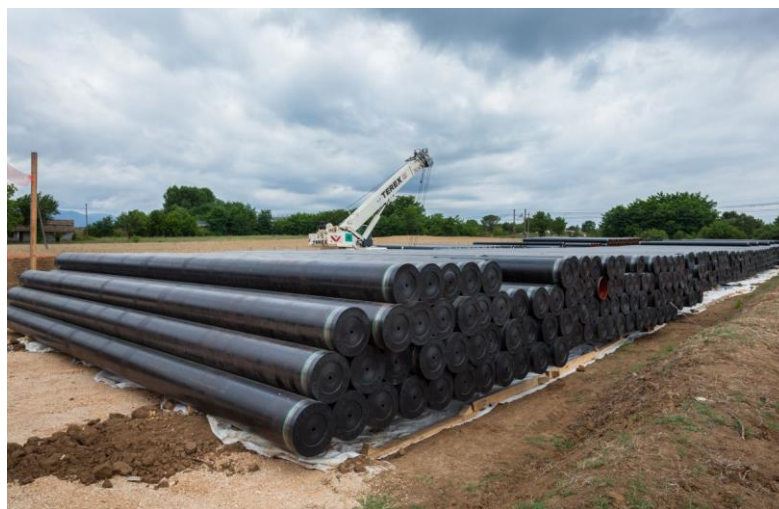
Figura 5.a: Foto Tipica di una Piazzola per Accatastamento Tubazioni
