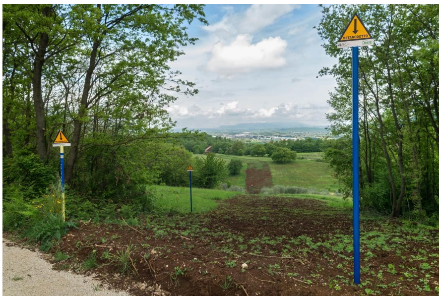
Figura 5.j: Esempio di Ripristino in Aree Agricole
