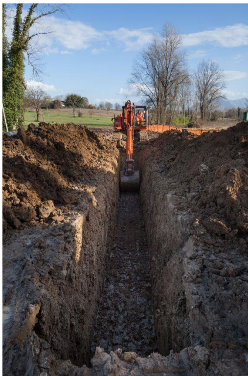
Figura 5.d: Foto delle Tipiche Operazioni di Scavo della Trincea
