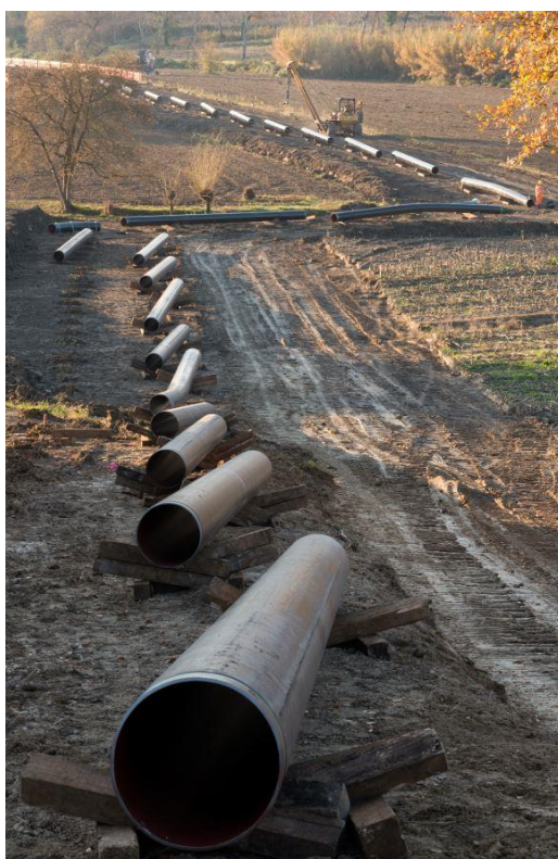
Figura 5.c: Foto delle Tipiche Operazioni di Sfilamento tubazioni
