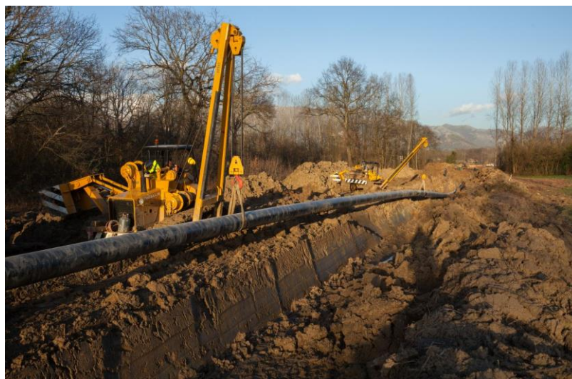
Figura 5.e: Foto delle Tipiche Operazioni di Posa della Condotta
