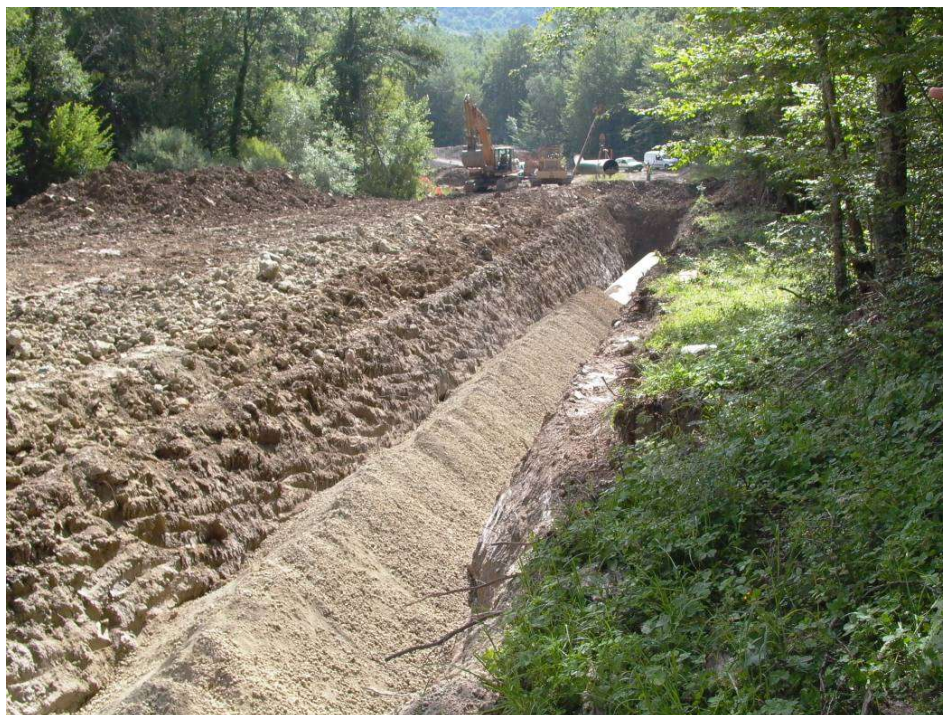
Figura 8.F: Rinterro della Condotta
