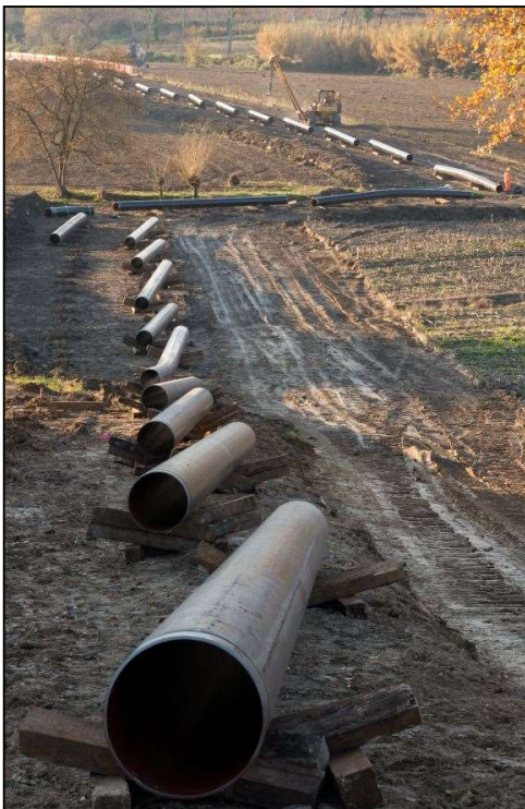
Figura 8.C: Sfilamento Tubi
