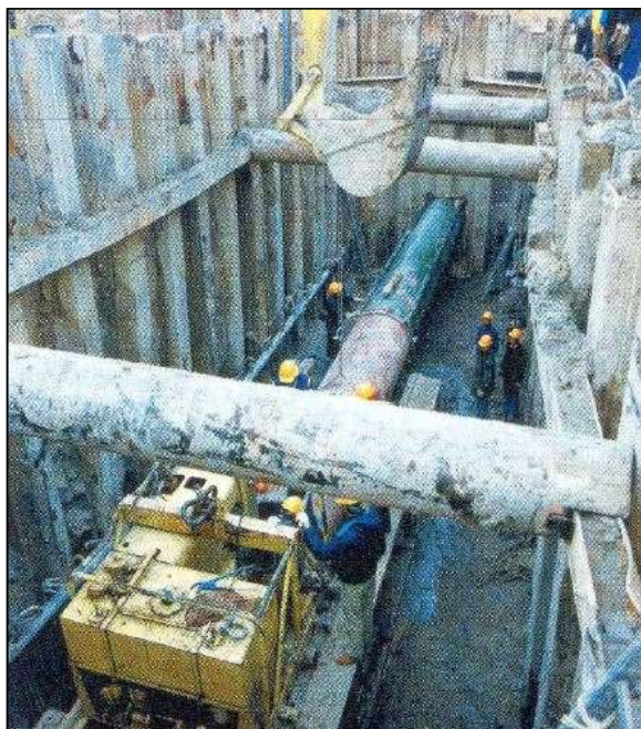
Figura 8.G: Macchina Spingitubo
