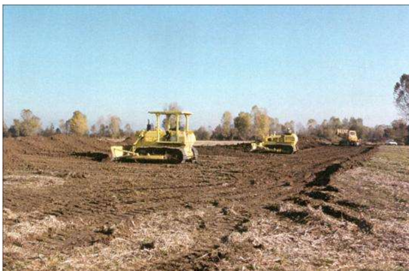
Figura 8.B: Apertura dell'Area di Passaggio
