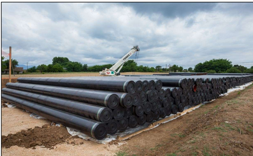
Figura 8.A: Piazzola per Accatastamento Tubazioni
