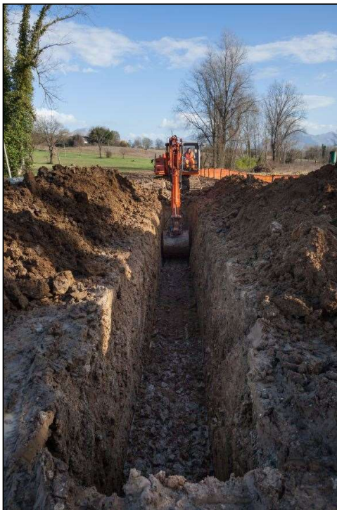
Figura 8.D: Scavo della Trincea
