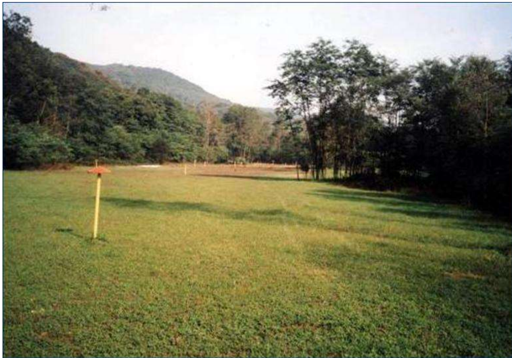
Figura 8.K: Pista di Lavoro a Ripristini ultimati su un Gasdotto in Esercizio
