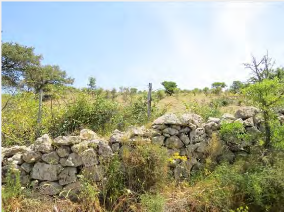
Panoramica UR 1. Veduta da nord est.
