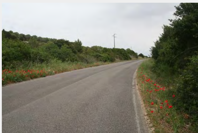
Panoramica UR1. Inizio tracciato, veduta da ovest.
