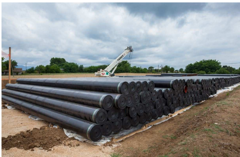
Figura 2.a: Foto Tipica di una Piazzola per Accatastamento Tubazioni
