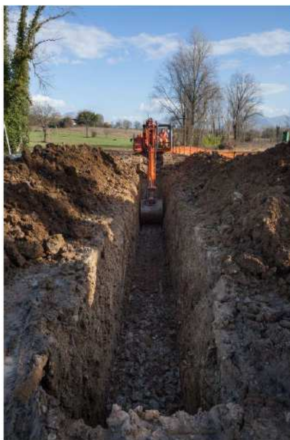
Figura 4.e: Foto delle Tipiche Operazioni di Scavo della Trincea
