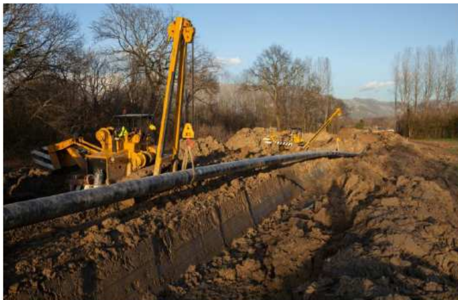
Figura 4.f: Foto delle Tipiche Operazioni di Posa della Condotta
