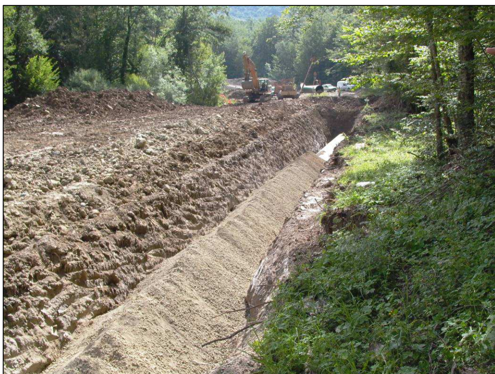
Figura 4.g: Rinterro della Condotta
