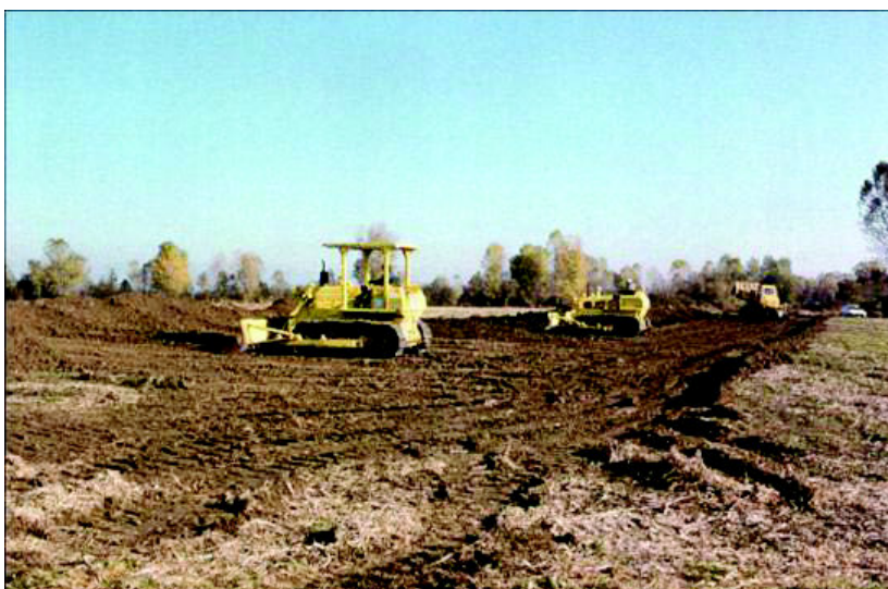
Figura 4.b: Operazioni Tipiche di Apertura dell'Area di Passaggio
