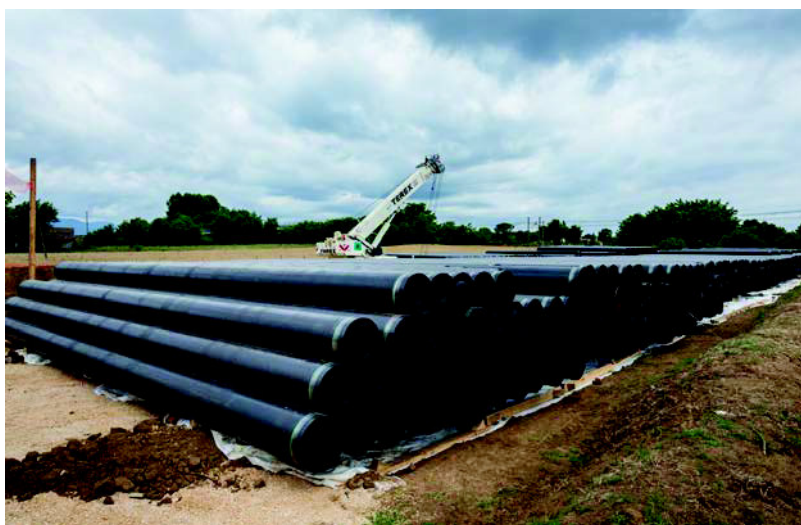
Figura 4.a: Foto Tipica di una Piazzola per Accatastamento Tubazioni
