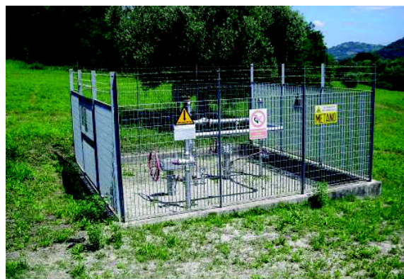
Figura 4.g: Esempi di Punti di Intercettazione di Linea (PIL)
